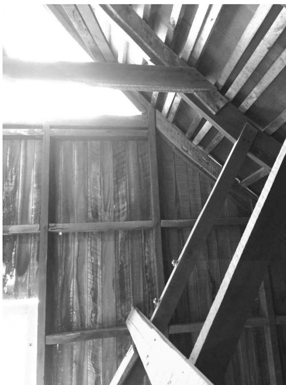
*Fig. 13. Encuentro del par curvo, torna punta y puente. Uniones carpinteras reforzadas con clavos.*
