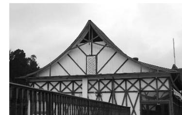
Fig. 12. Cubierta configurada a partir de par curvo.
