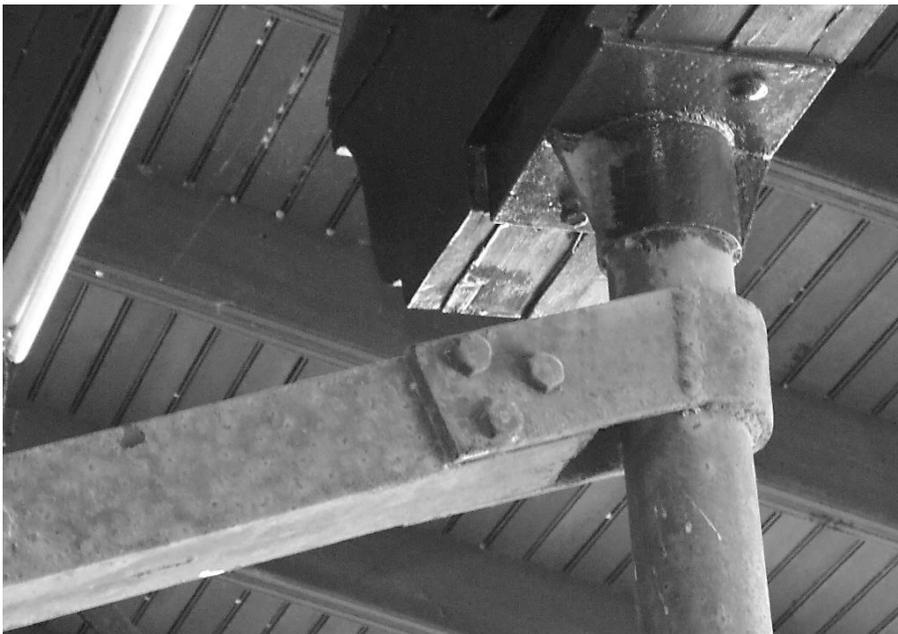
*Fig. 7.2. Conexión superior entre riostra y perfil tubular estructural correspondiente al eje C.*
