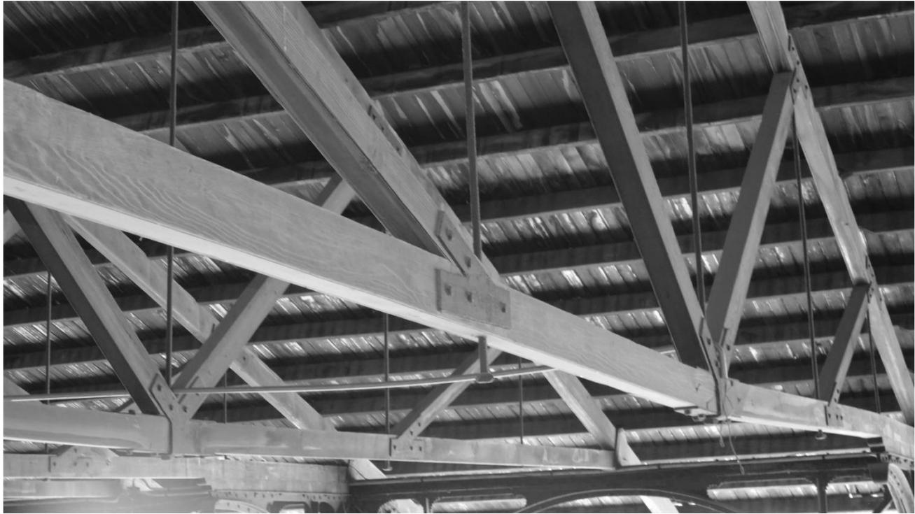
*Fig. 4. Fotografía cubierta, se percibe tirante de madera deformado y tirantes de hierro no sometidos a tracción.*
