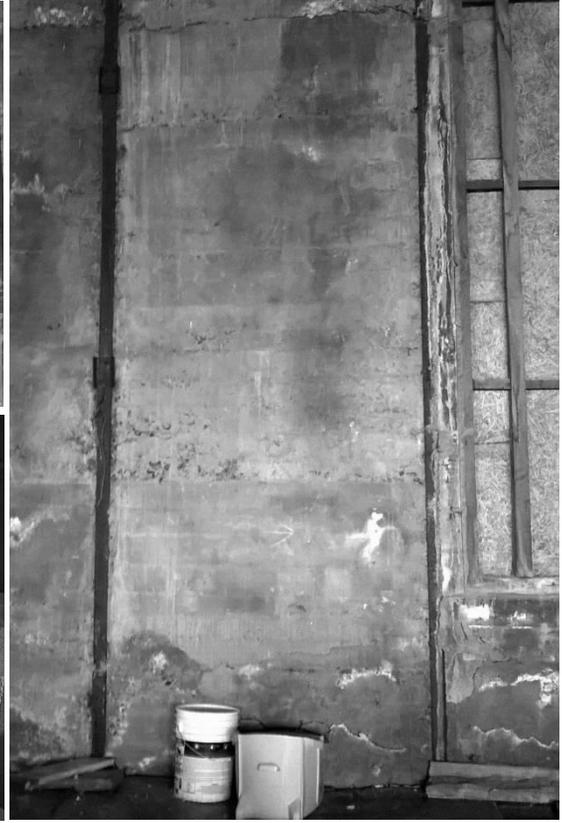
*Escuela Naval, detalle muro armado con perfiles de hierro.*
