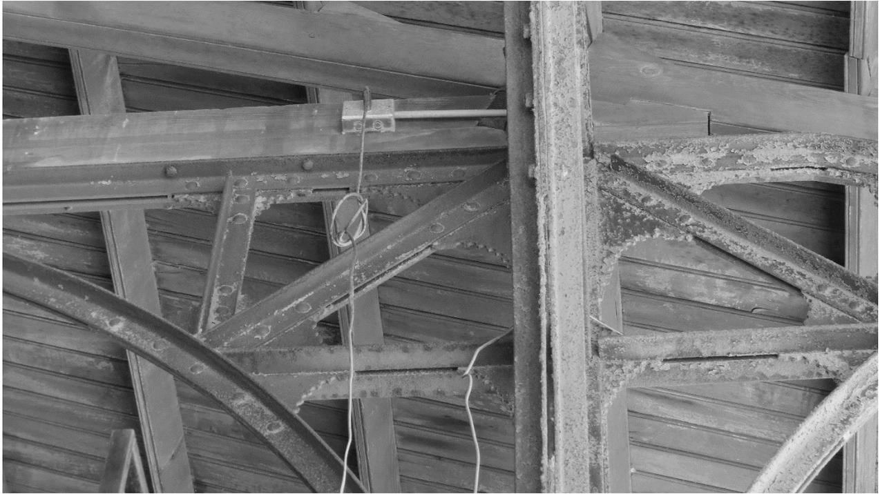
*Fig. 10.1. Detalle unión pilar –tirante mediante una mensula.*
