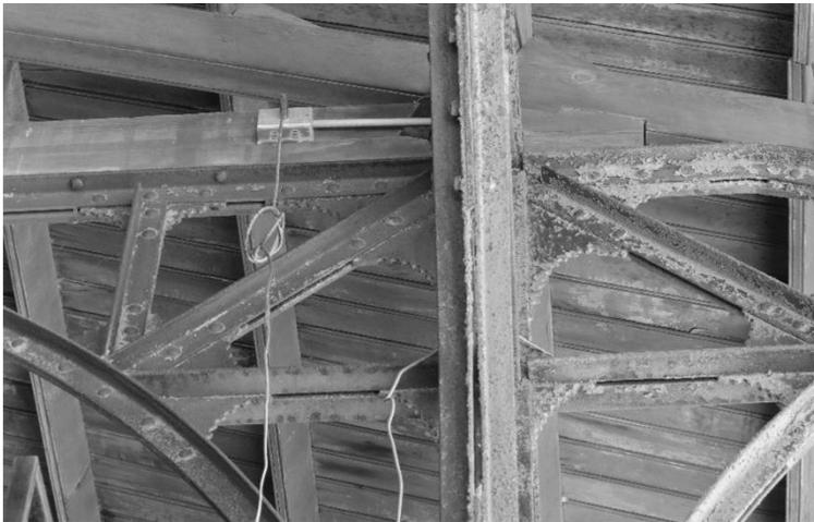
*Encuentro par-tirante-ménsula eje A. Desplazamiento mínimo debido a empotramiento mediante cartela simétrica en ambos ejes.*
