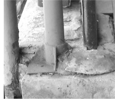
Fig. 5. Placa base tubular rigidizada en ambos planos.
