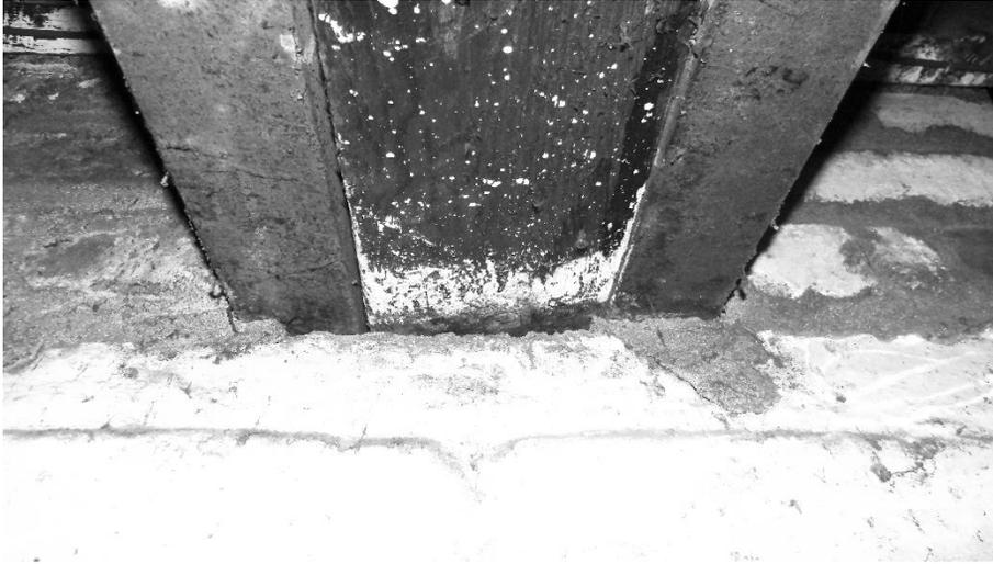
*Fig. 3.2. Detalle unión viga compuesta simplemente apoyada en pilares de albañilería.*
