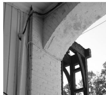
*Fig. 2.1 pilar de albañilería 100x125 + arcada rebajada.*
