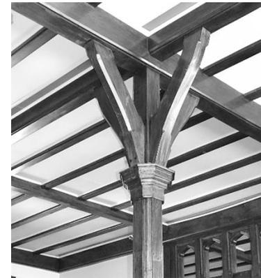
Fig. 11. Pie derecho decorado con tornapuntas. Refuerzo de viga en ambos ejes.
