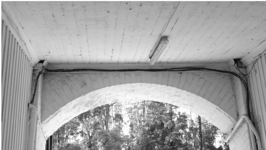
*Fig. 2. Encuentro arco rebajado con pilares de albañilería.*
