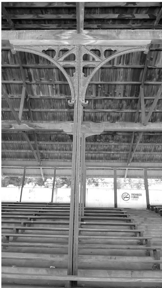
*Fig. 7.1. Cubierta dos aguas a partir de viga armada.*
