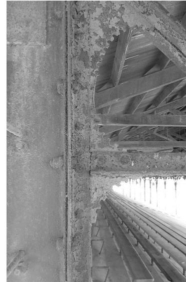
*Fig. 8. Detalle unión remache y pernos.*
