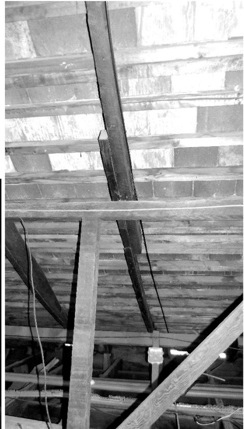
En cuanto a la construcción de la curva del par, la solución constructiva aplicada para concebir la curva, es a partir de piezas ortogonales mediante un rebaje oblicuo que permitía inclinar la pieza en el porcentaje deseado.
