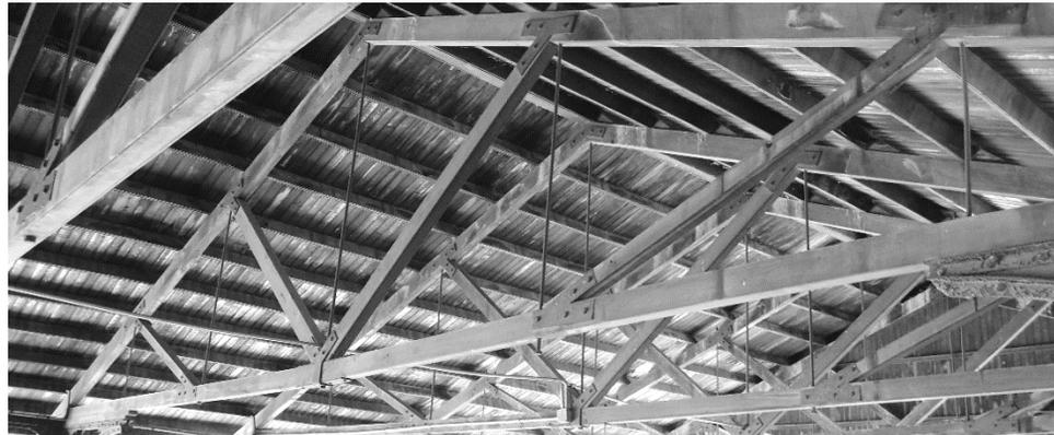
*Fig. 9. Cubierta dos aguas a partir de viga armada.*
