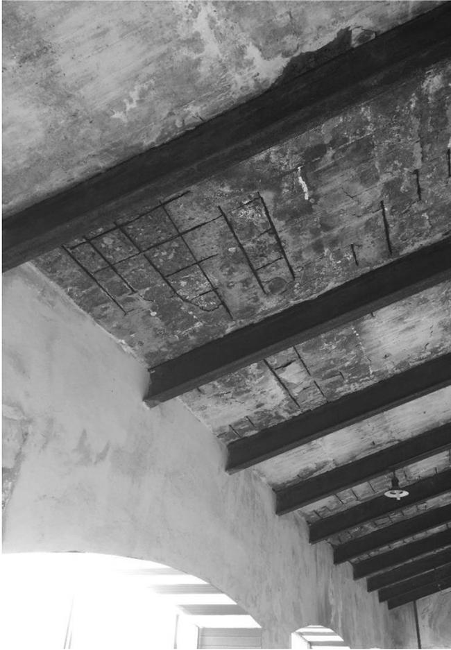
*Fig. 5. Sucesión de vigas transversales que soportan losa de tribunas.*
