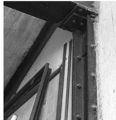
Fig. 4. Pilar reforzado con placa de hierro en alas mediante remaches.
