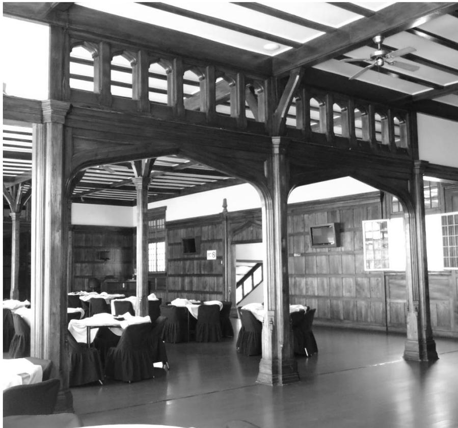
*Fig. 10. Jácena con doble Jabalcón que rigidizan la viga en el eje transversal soportada por tres pilares.*
