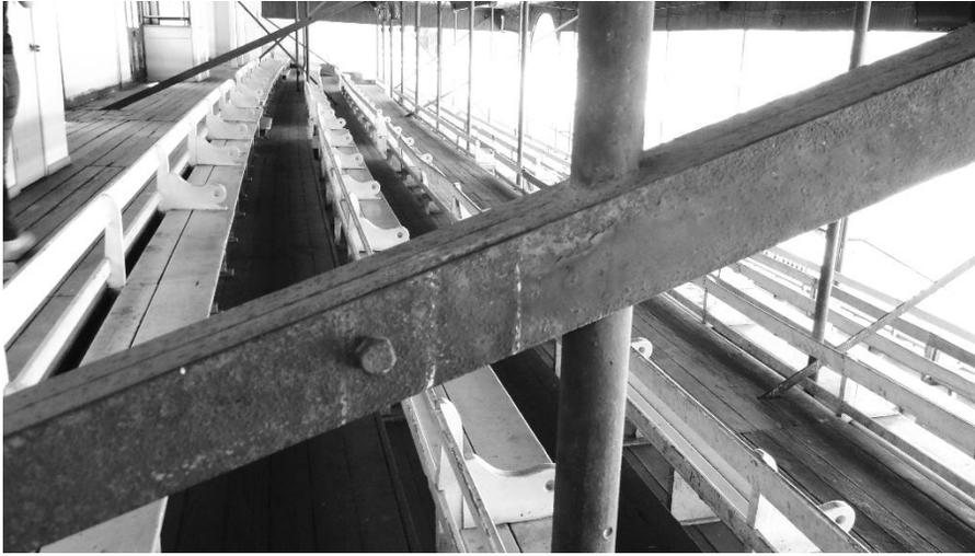
*Fig. 8. Conexión intermedia entre riostra y perfil tubular estructural correspondiente al eje D.*
