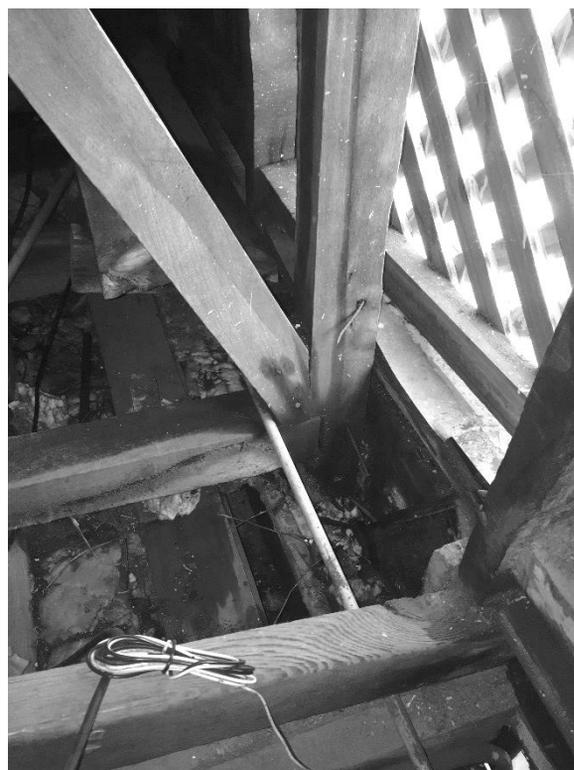
*Fig. 14. Encuentro solera inferior, hilera y diagonal de arrostramiento. Uniones carpinteras reforzadas con clavos.*
