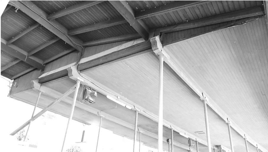
*Fig. 4. Inclinación de la cubierta de acuerdo a la carga aplicada en el tercer nivel.*
