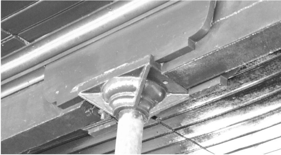
*Fig. 7.1. Empalme de viga de doble sección rigidizada por una pieza similar a la sopanda que abraza y refuerza la unión. El elemento vertical recibe a la viga mediante una placa asiento de hierro fundido.*
