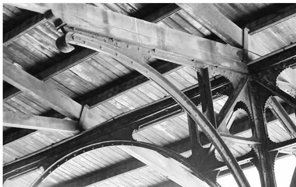
*Fig. 10. Detalle unión pilar-ménsula-tirante.*
