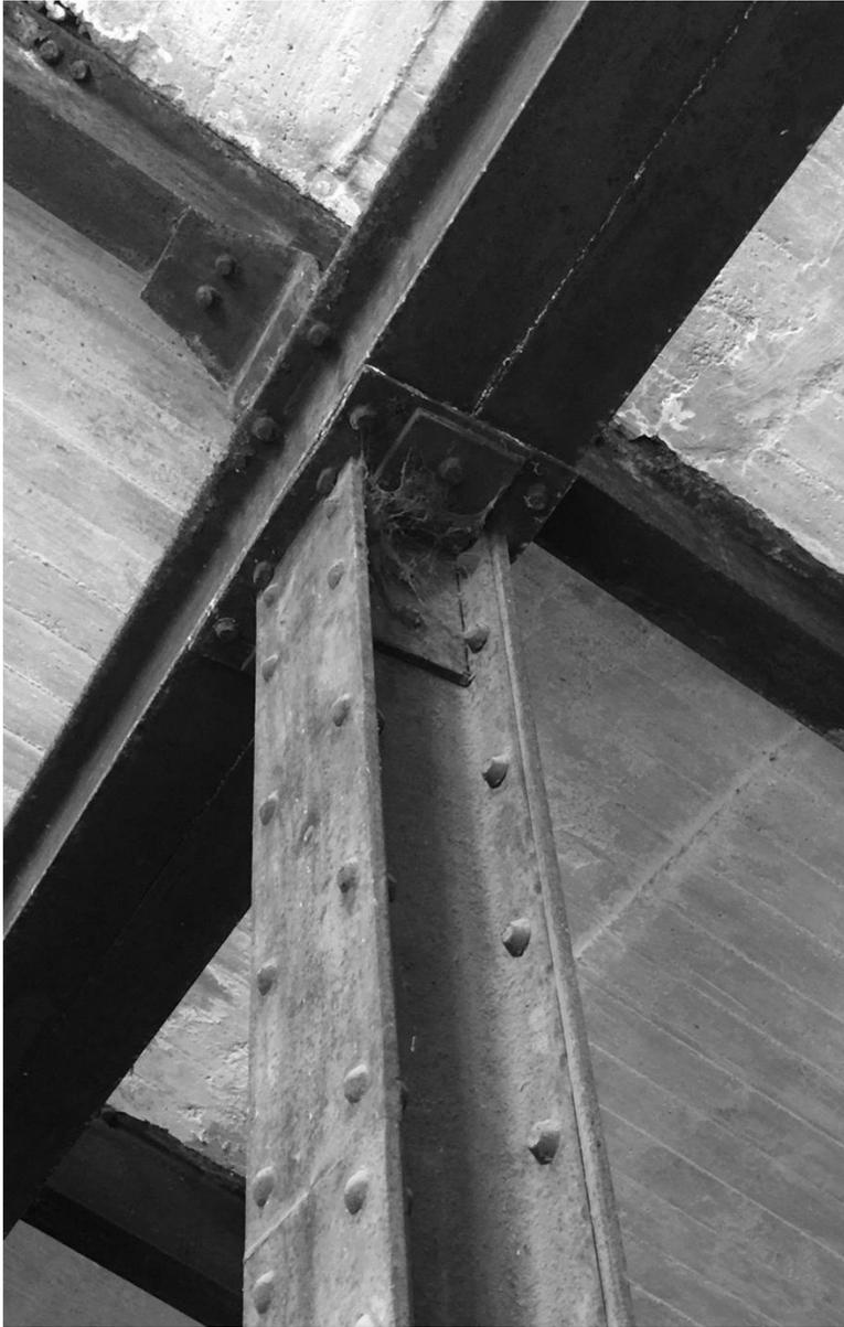
*Fig. 5. Detalle unión pilar compuesto, reforzado en alas.*
