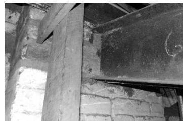
*Fig. 3.1. Apoyo simple: viga compuesta- pilar albañilería.*
