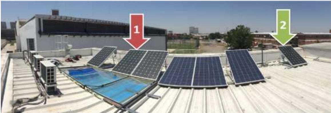
*Figura 4.1 A la izquierda con el N°1 los paneles PV con estructura de reflectores y a la derecha con el N°2 el panel PV sin reflector [16].*
