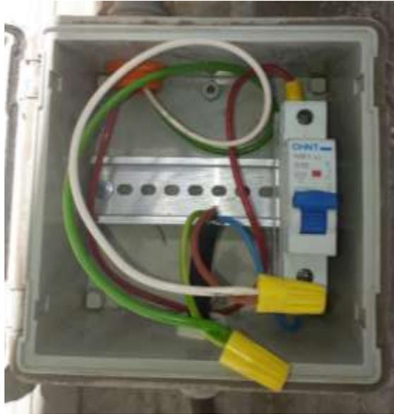
*Figura 4.3 Elemento de seguridad N°1, interruptor automático AC.*
