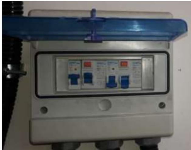
*Figura 4.4 Elemento de seguridad N°2, por el interruptor automático y diferencial de lado izquierdo*
