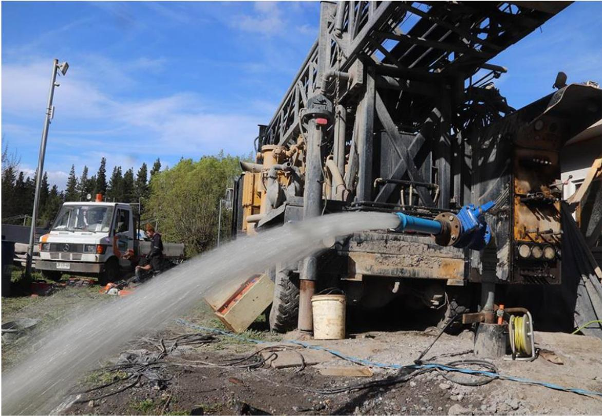
Figura 1-15 Pruebas de bombeo del pozo de extracción en Liceo Bicentenario Altos del Mackay
