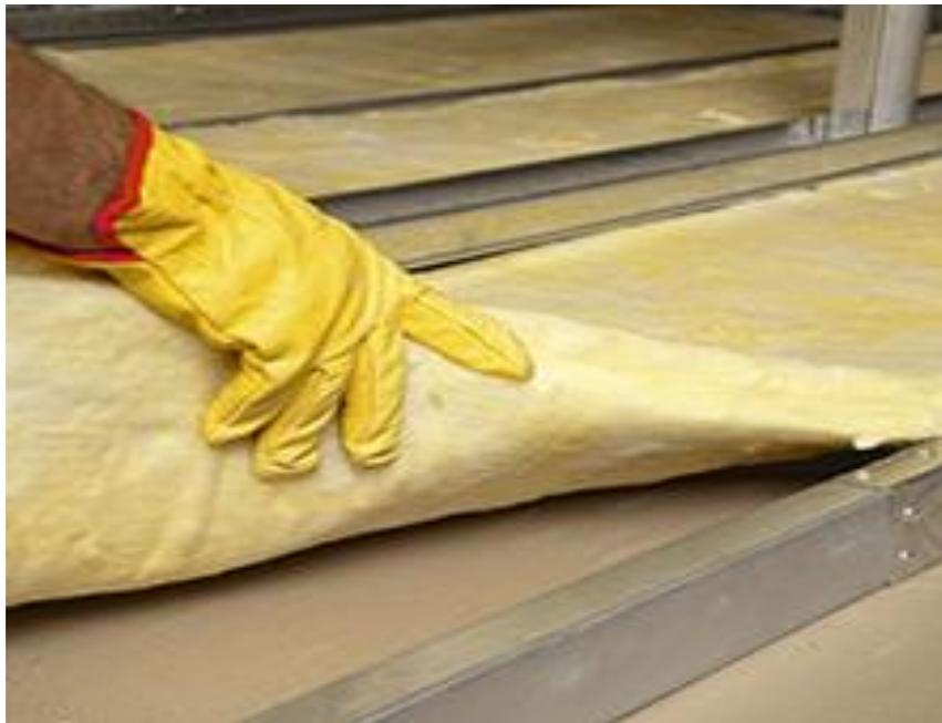
Figura 3-2 Instalación de lana Mineral sobre cubierta en entretecho
