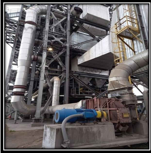
*Figura 1- 27 Ventilador aire secundario*
