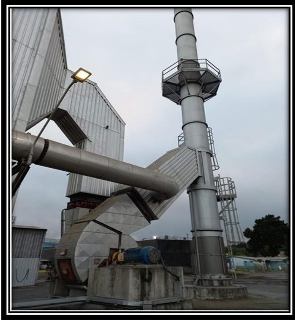
*Figura 1- 23 Ventilador extractor*
