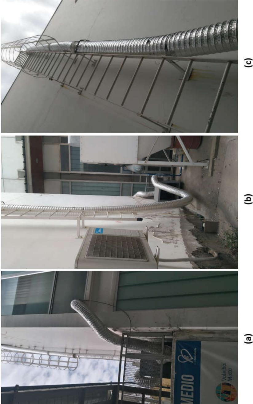
Figura 8.8: Registro de la extracción de la cortadora láser vista por fuera del laboratorio, 10 de septiembre del 2019 (a) Salida directa del tubo de extracción por una perforación en la ventana (b) Continuación del tubo por el costado exterior oriente del laboratorio (c) Final del tubo por la parte superior del edificio.
