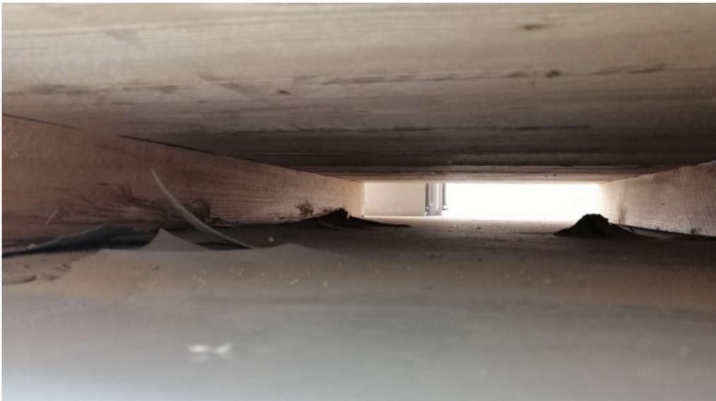
Figura 8.37: Registro del espacio al día 12 de marzo del 2020, fracturas en el piso bajo la caja de la máquina sinterizadora.
