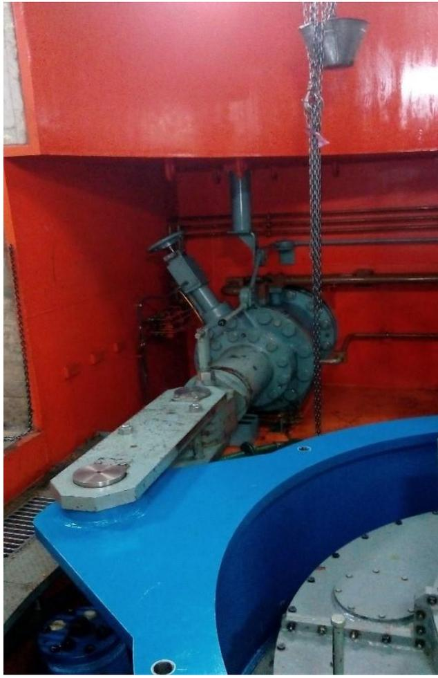
Figura 2-8.- Servomotor N°1
