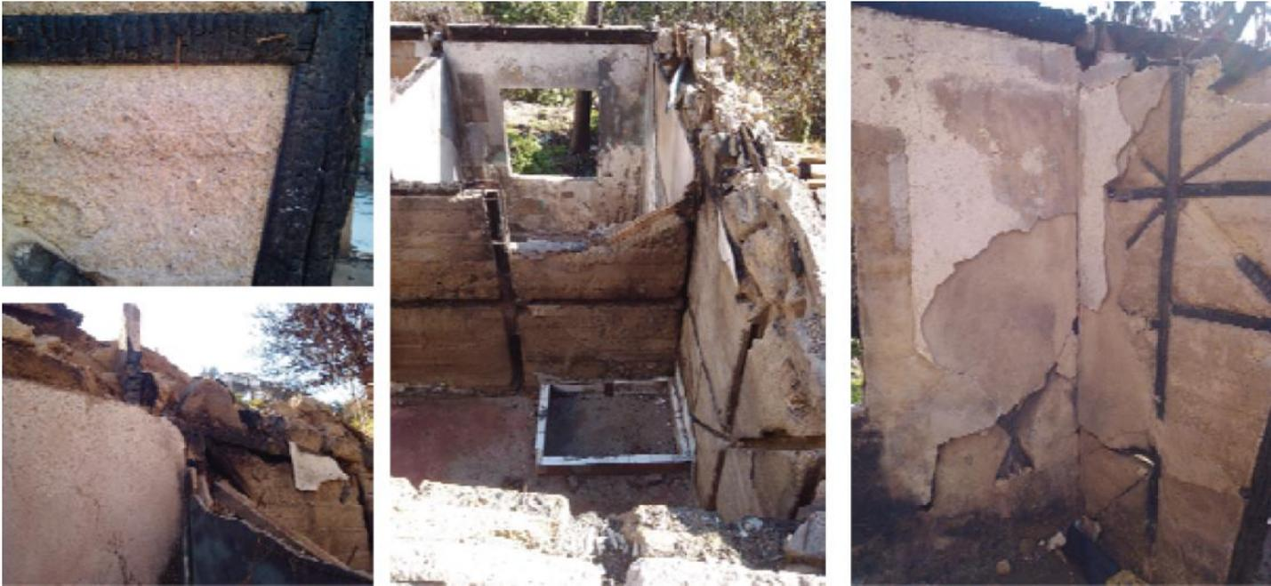
(Figura 6 – Casa de Adobe con Madera Estucado con Mortero de Cemento)
