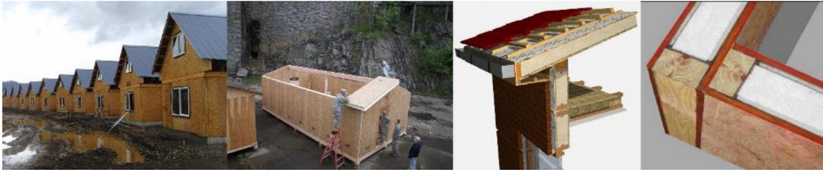
El Panel SIP (Structural Insulated Panel) o Panel Sándwich OSB, un moderno y completo sistema estructural auto soportante usado para la construcción, conformado por un alma de espuma rígida de Poliestireno de alta densidad (EPS).
