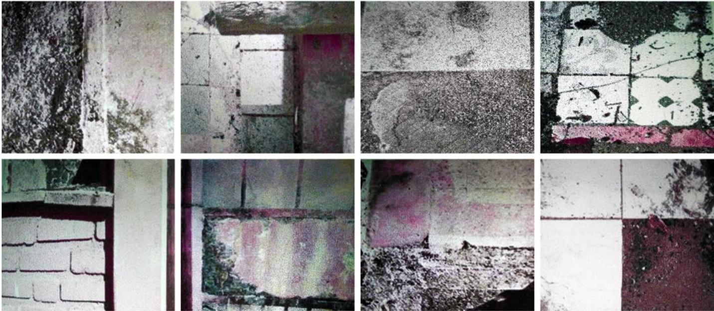
*(Figura 8 – Registros de revestimientos que resistieron incendios)*
