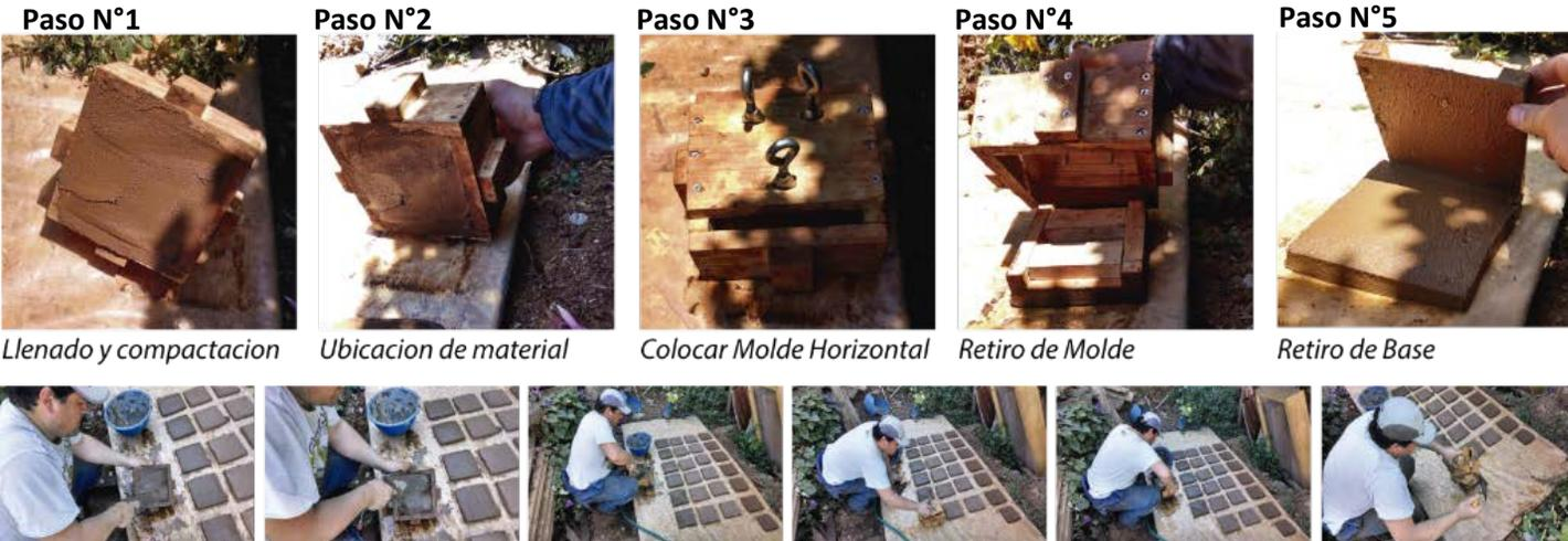
(Figura 15 – Aplicación de Máquina de Probetas)
