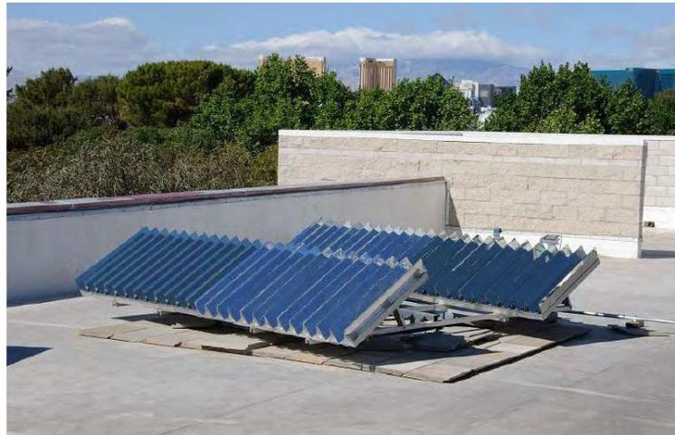
Figura 16: Concentrador solar fotovoltaico con seguimiento en un eje [18]
