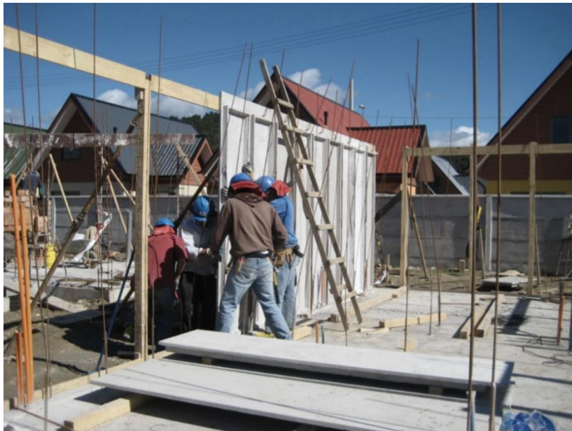
Figura N°6.1: Montaje en obra. Fuente: Cementos Bio-Bio.
