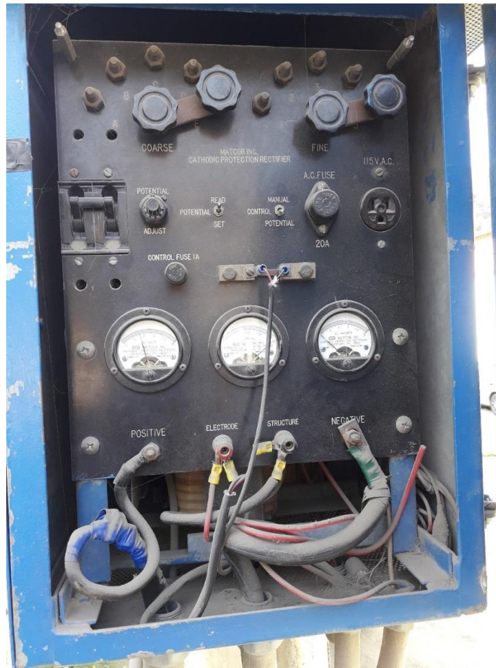
Figura 1-3. Sistema de protección catódica, corriente impresa a través de rectificador.
