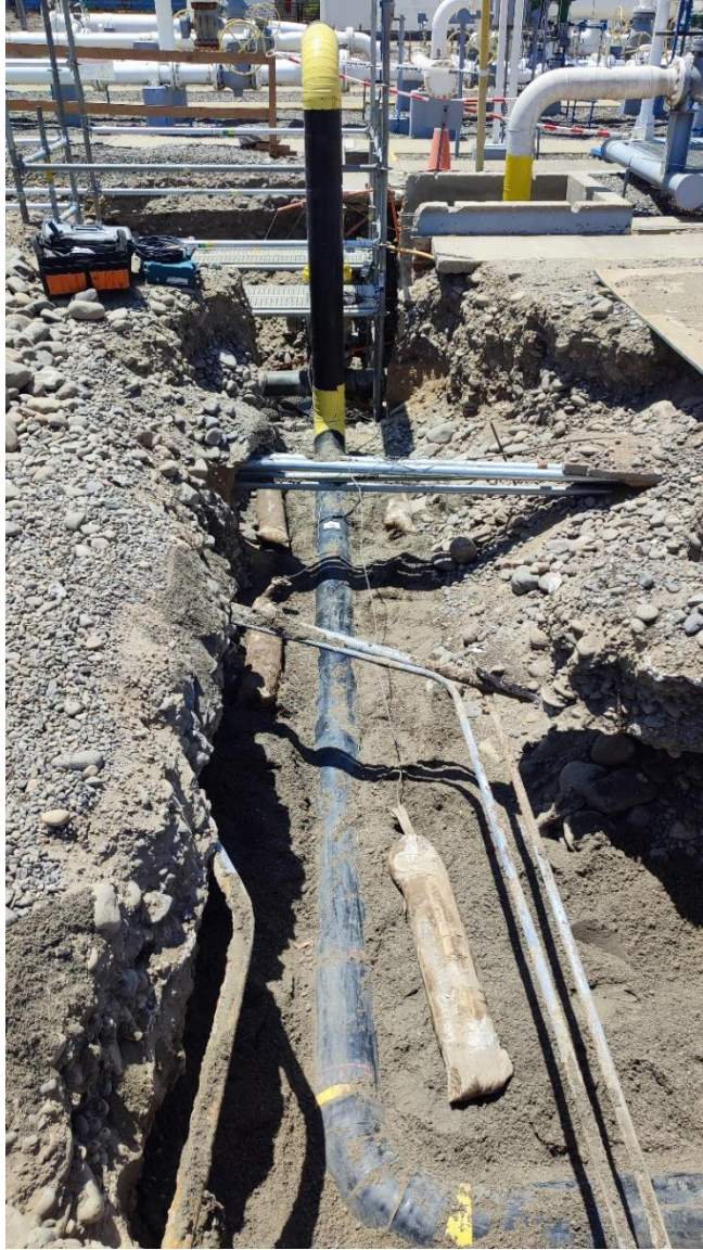
Figura 1-2. Sistema tradicional de protección catódica, ánodos de sacrificio.
