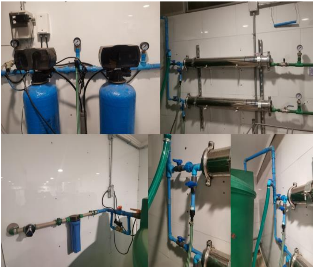
Figura 2-6. Filtros y estanques sin medidores
