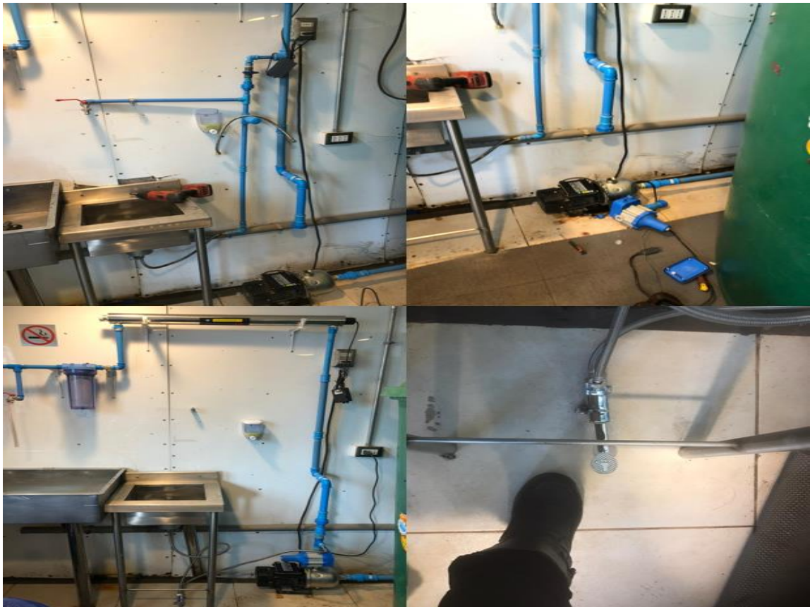
Fuente: fotografía personal de recambio de válvula en sector de lavado interior de bidones.
