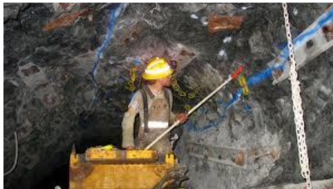
Figura 26: Sistema de conexión de voladura
