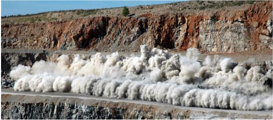
Figura 7: Voladura en campo. Fuente (EPC-Groupe)
