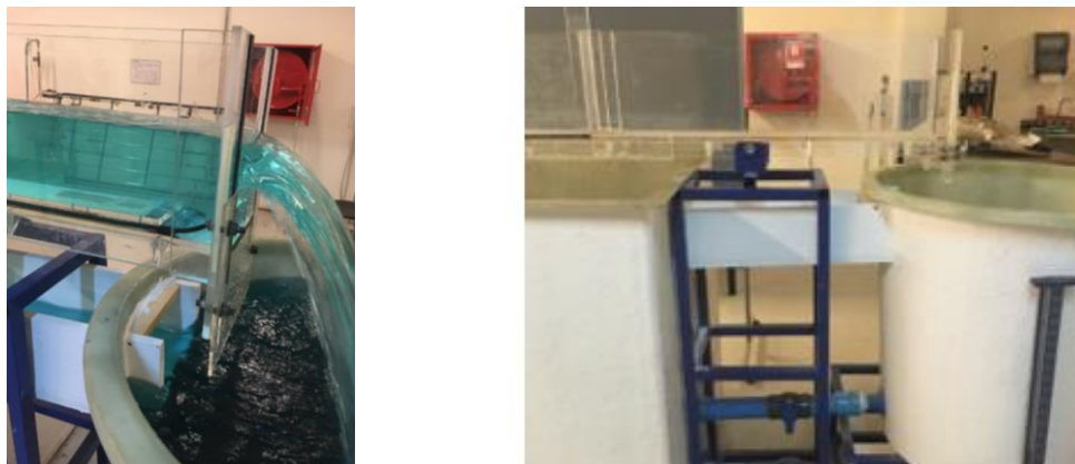
Figura 5.9: Instalación sistema de rebalse
