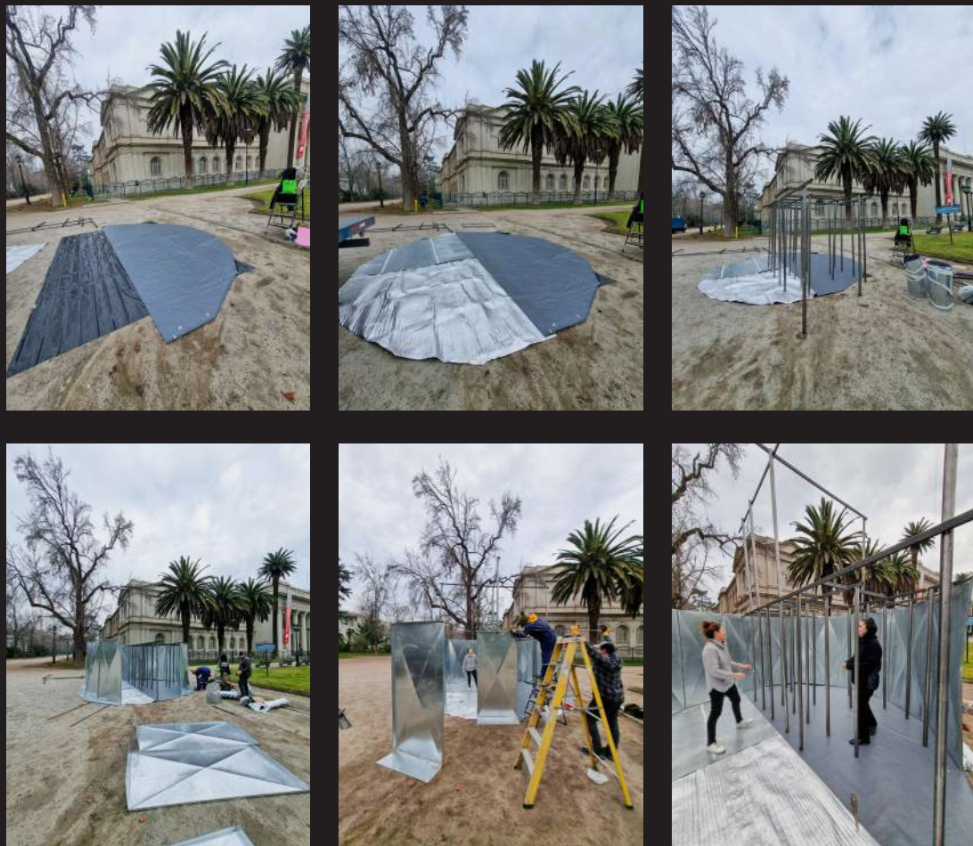
fig. 96. Compilado de fotografías del proceso de montaje en el lugar de emplazamiento. Elaboración propia.
