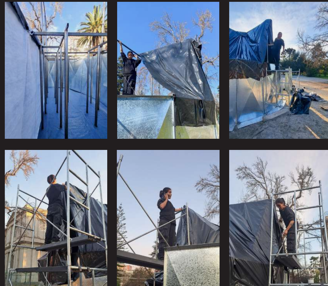
fig. 99. Compilado de fotografías del proceso de montaje en el lugar de emplazamiento. Elaboración propia.
