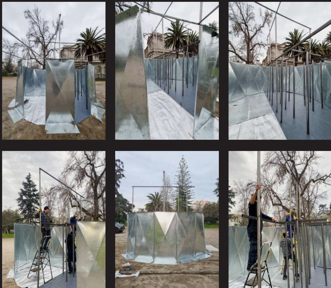
fig. 98. Compilado de fotografías del proceso de montaje en el lugar de emplazamiento. Elaboración propia.
