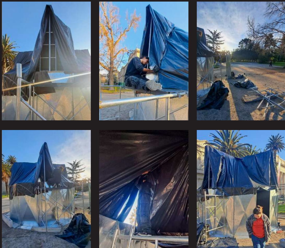
fig. 100. Compilado de fotografías del proceso de montaje en el lugar de emplazamiento. Elaboración propia.
