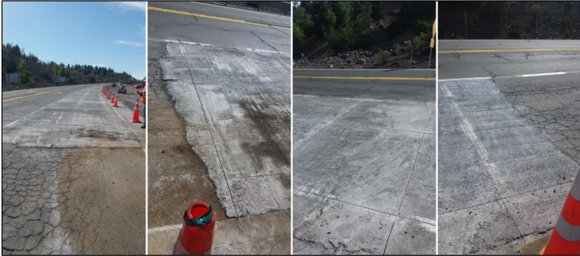
Figura 5-14: Pavimentación con Losas Cortas km 41 - Pavimento Terminado.
