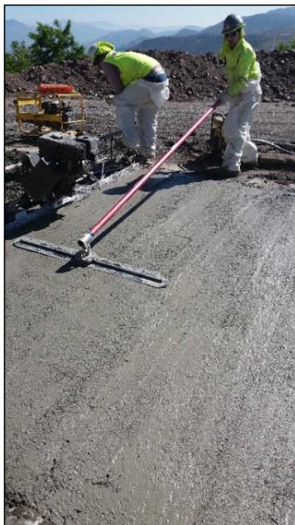
Figura 5-9: Pavimentación con Losas Cortas km 41 – Terminación.
