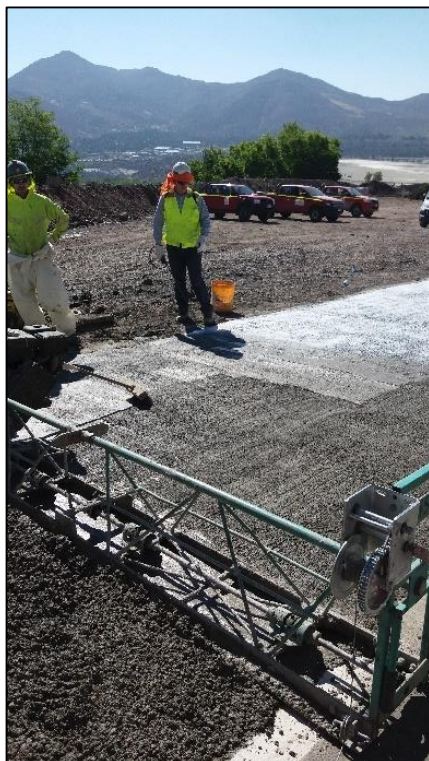
Figura 5-10: Pavimentación con Losas Cortas km 41 – Textura Superficial.
