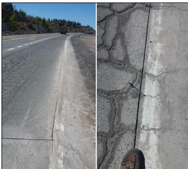
Figura 5-2: Pavimentación con Losas Cortas km 41 – Cortes de Asfalto Existente.
