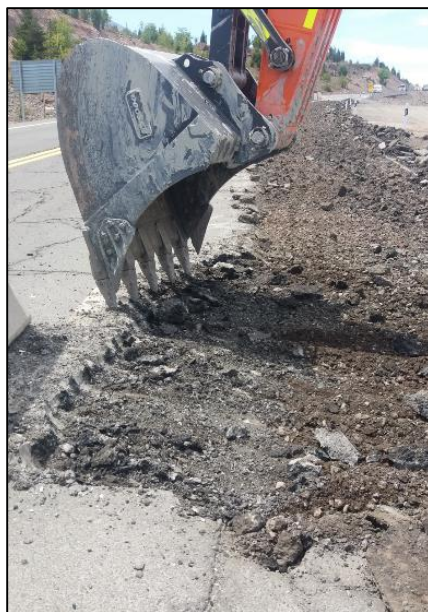
Figura 5-4: Pavimentación con Losas Cortas km 41 – Franja de Asfalto de Mayor Espesor.
