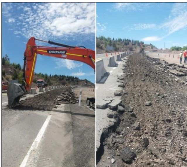
Figura 5-3: Pavimentación con Losas Cortas km 41 – Retiro de Asfalto Existente.
