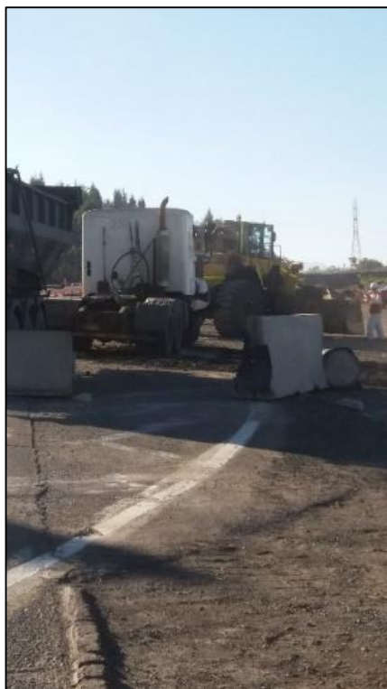
Figura 5-18: Inconvenientes Pavimentación km 41 – Accidente Martes 6 de diciembre.
