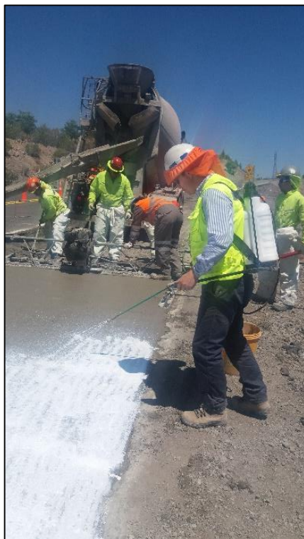
Figura 5-11: Pavimentación con Losas Cortas km 41 - Aplicación Membrana de Curado.
