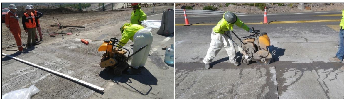
Figura 5-13: Pavimentación con Losas Cortas km 41 - Cortes Transversales (izquierda) y Longitudinales (derecha) del Pavimento.
