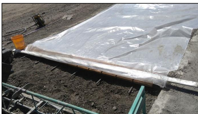
Figura 5-12: Pavimentación con Losas Cortas km 41 - Junta de Construcción.
