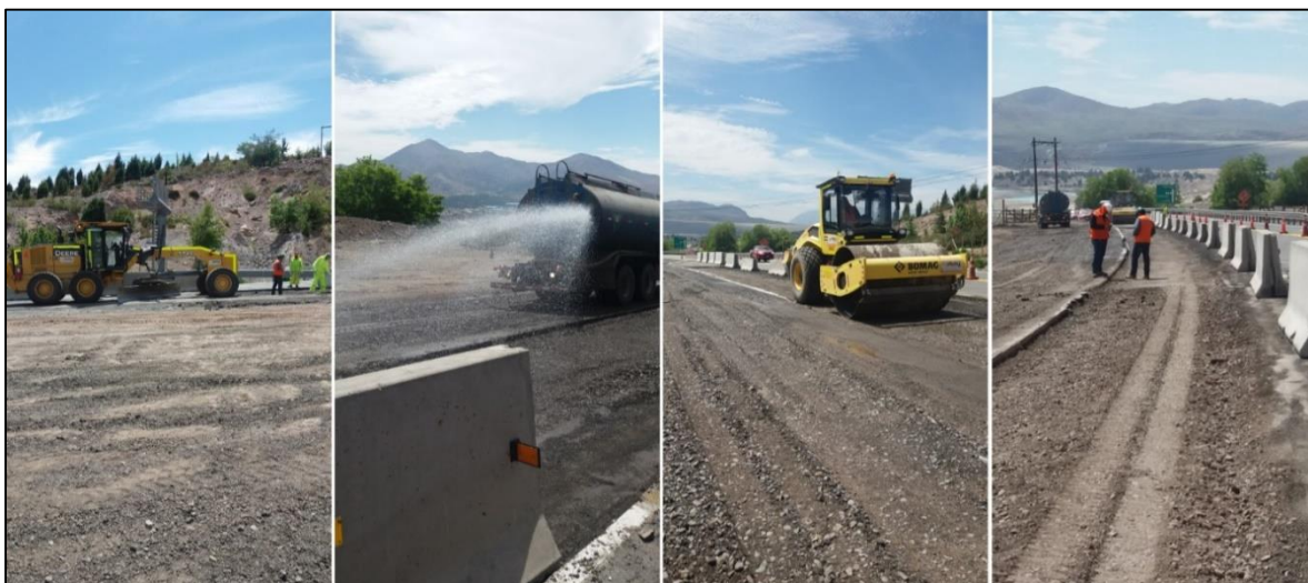
Figura 5-6: Pavimentación con Losas Cortas km 41 - Preparación de la Subrasante
