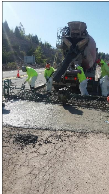
Figura 5-8: Pavimentación con Losas Cortas en km 41 - Colocación Hormigón.
