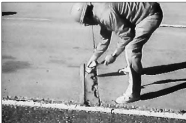
Figura 2-5: Pavimentos de Hormigón-Desprendimiento en las Juntas (Delatte, 2007).
