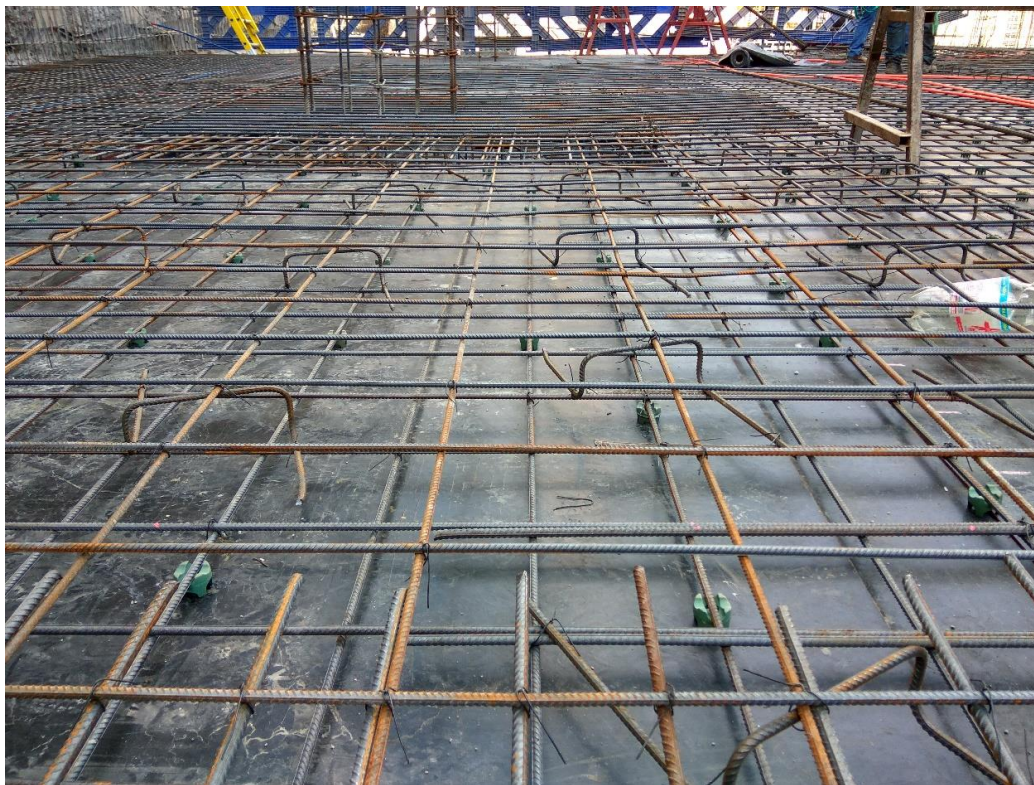
Figura 6-4. Instalación de Patas o Sillas en Armadura de Losa. Fuente: Fotografía propia.
