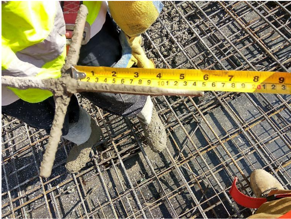
Figura 7-16. Marcador de Losa o "Chapulina" para el caso de 15 cm de espesor
