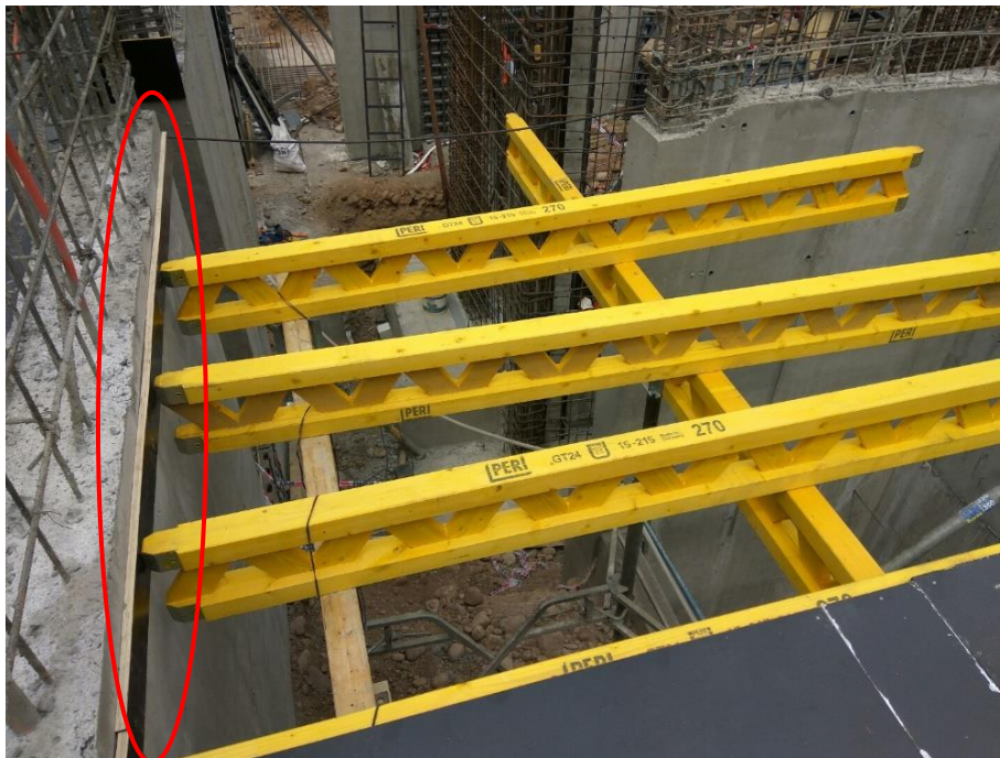
Figura 7-8. Imagen de Solera en Moldaje de Losa Fuente: Fotografía propia.
