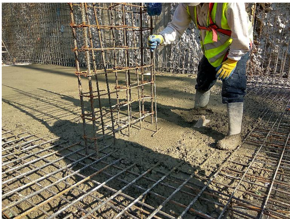
Figura 7-15. Trabajador utilizando marcador para espesor de losa.
