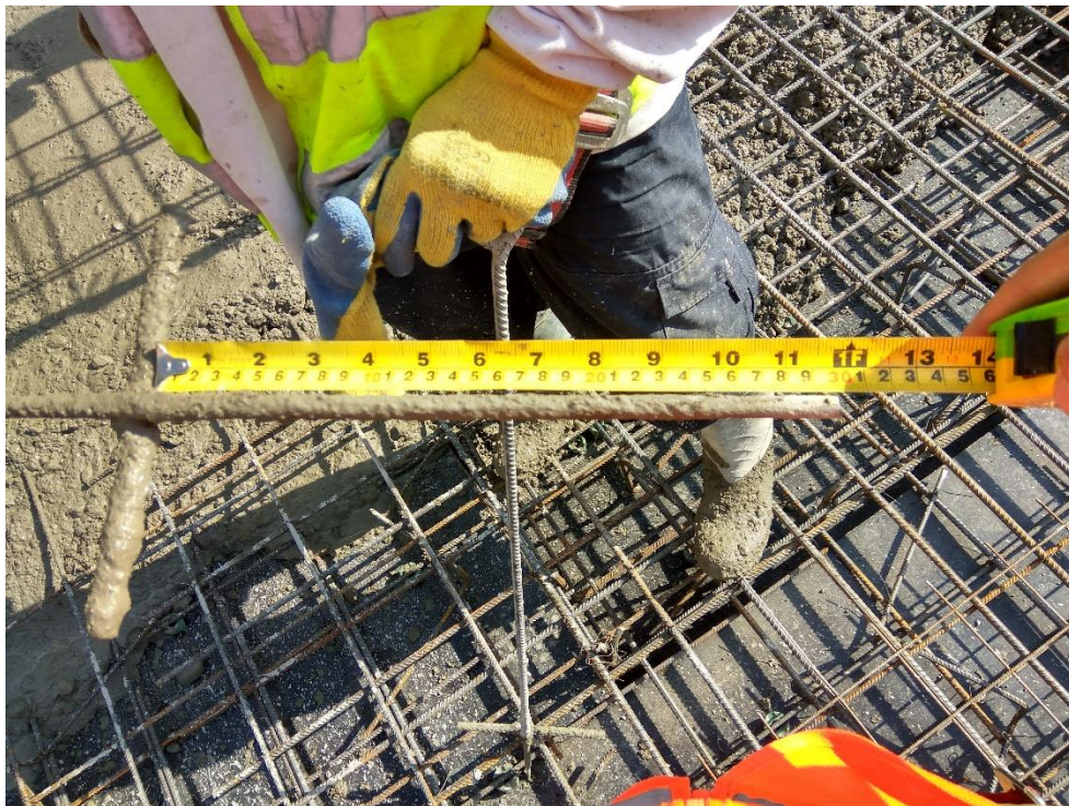
Figura 7-17. Marcador de Capitel o "Chapulina" para el caso de 30 cm de espesor
