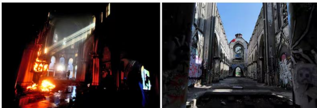
Figura 9. Incendio y deterioro de iglesia San Borja (Gómez, 2022).
