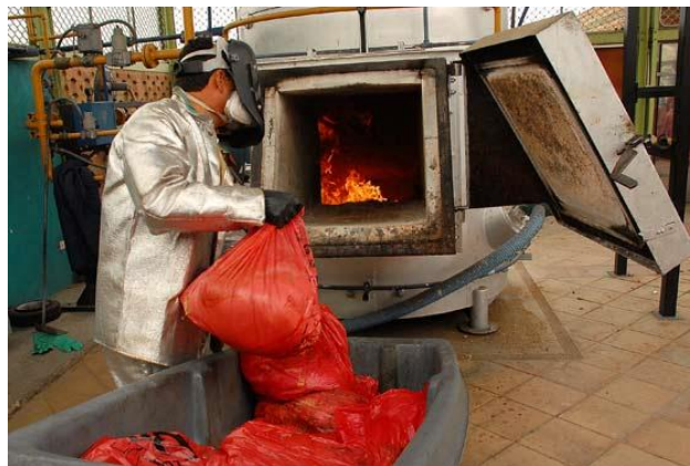
Figura 5.4 Entrada a un horno incinerador
