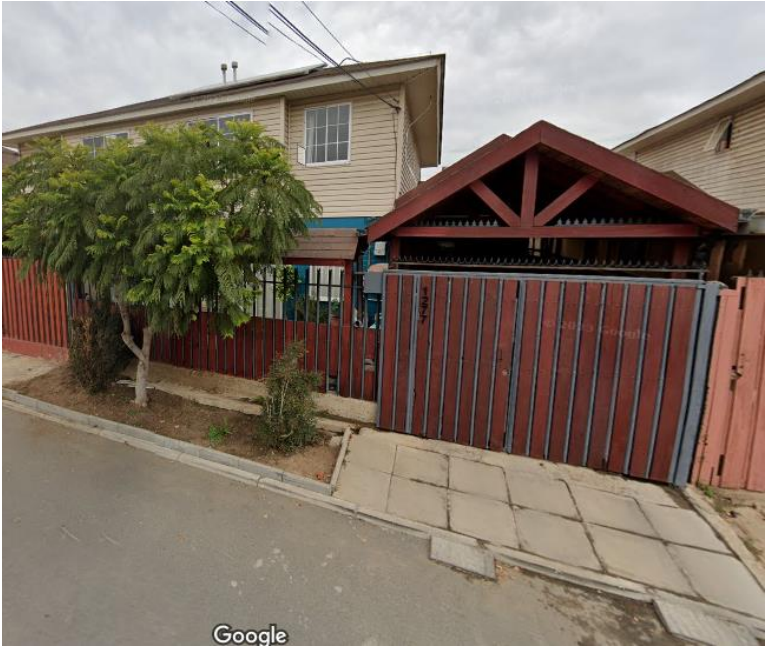
Fuente: Casa propia. Figura 1-2. Casa empresa.
