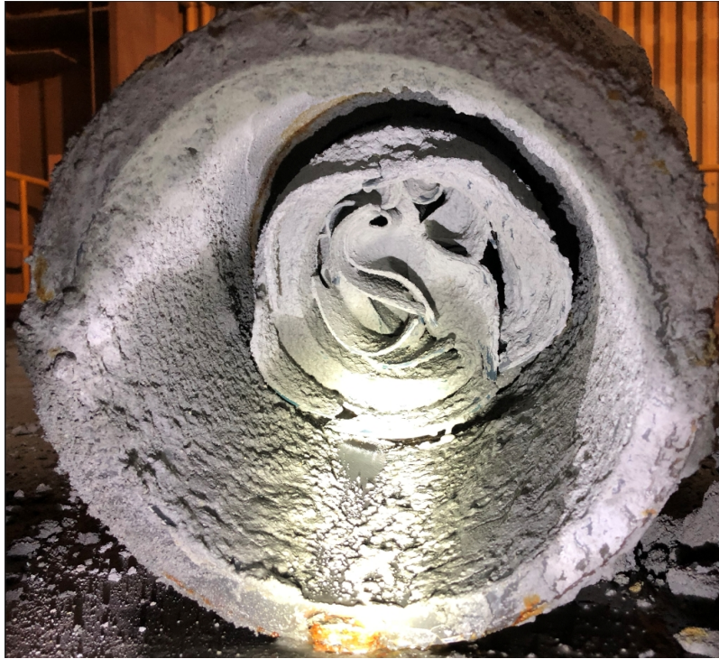
Figura 2.16: Obstrucción de apex por carpetas plásticas externas.
