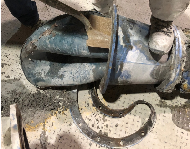
Figura 3.7: Personal de empresa colaboradora retirando revestimiento de caucho que tenía embancado al ciclón.
