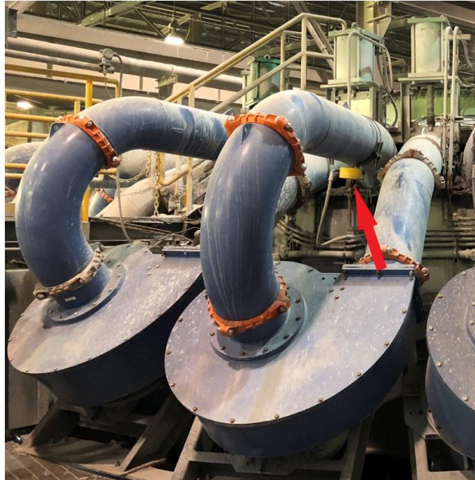
Figura 2.22: Montaje de PST (de color amarillo) en ducto de descarga overflow .
