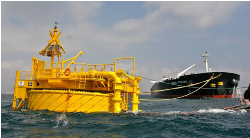
Figura 3.1: Monoboya ubicada en Tarragona, España ( Ministerio de Obras Públicas, 2013a )
