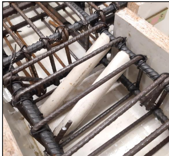
Figura 28 Colocación de tubos para cámaras endoscópicas en 30° para armadura tradicional
