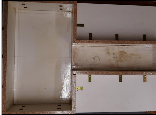
Figura 32 Moldaje con aplicación de desmoldante un día previo al hormigonado
