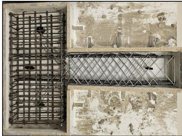
Figura 33 Instalación de separadores para columna y viga
