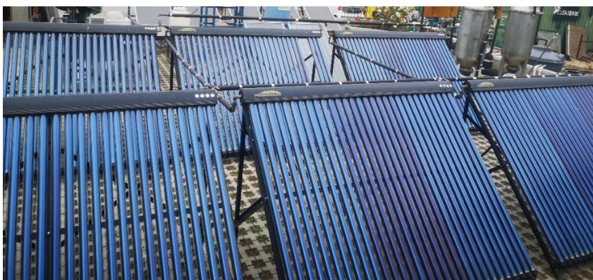
Figura 3-1 Tubos Heat Pipe conectados.
