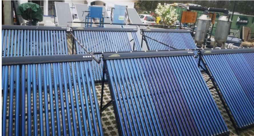
Figura 4-8 Sistema colector, planta HDH de dos etapas.
