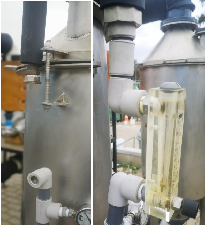
Figura 3-5 Nueva unión americana instalada
