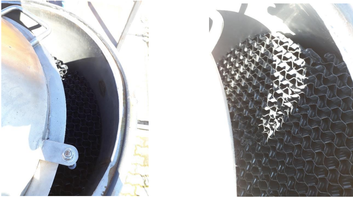
Figura 3-6 Relleno evaporativo humidificador inferior
