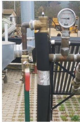
Figura 3-2 Válvula de cierre sistema colector
