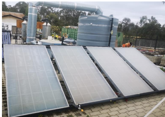
Figura 4-2 Sistema colectores, planta HDH de una etapa
