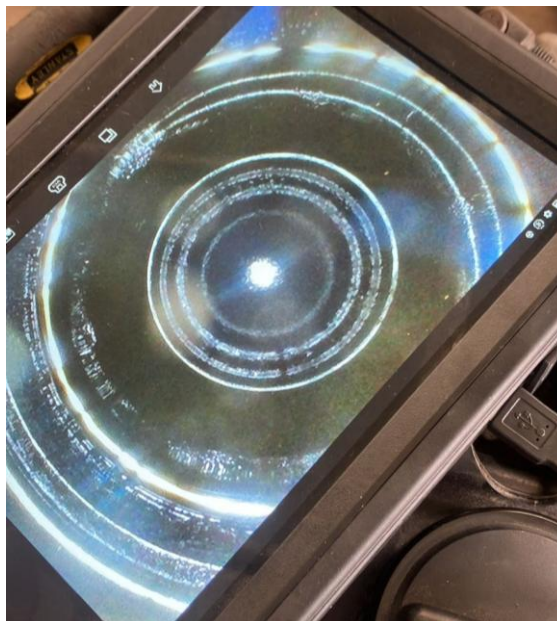
Figura 5: Inspección visual interna.
