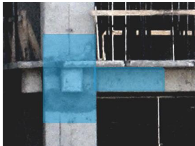
Figura 1. Zona de interés en un marco de hormigón armado
