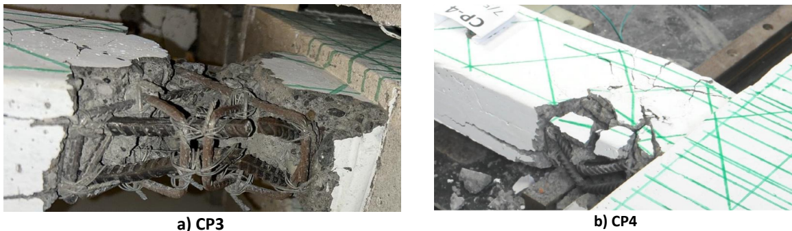
Figura 10. Daño en probetas posterior al ensayo (Pino 2017)
