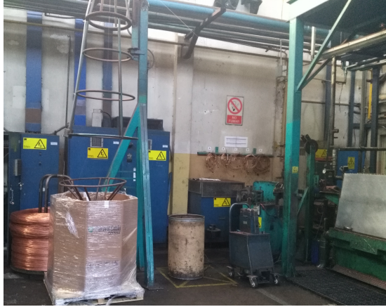
Figura 2.9: Entregador de torre no controlado
