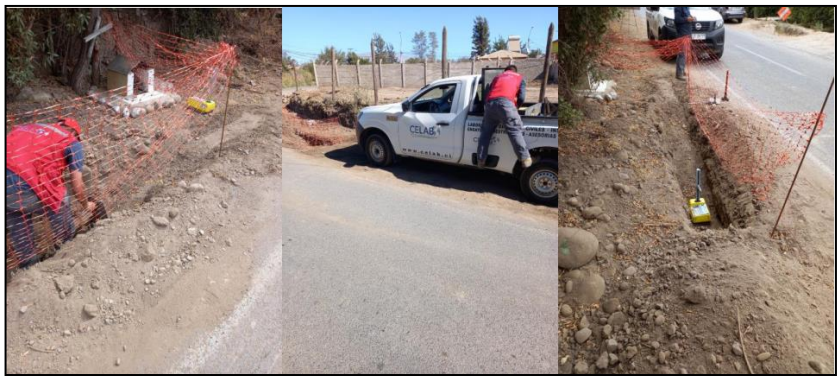
Fuente: Empresa CCZ Ingeniería, tomada en terreno en la comuna de San Esteban, [2022].
