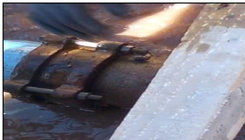
Figura 1-4. Unión brida gibault.
