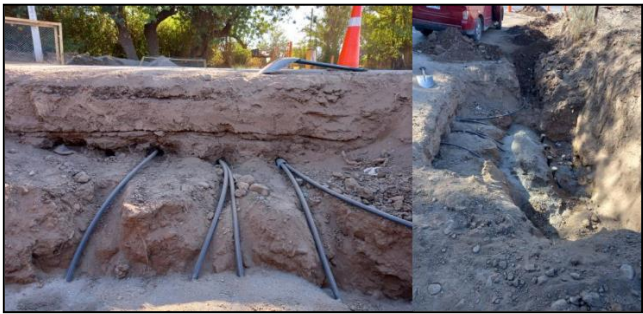
Figura 3-13. Encamisado de cinco arranques.
