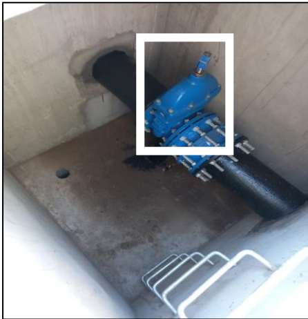
Fuente: Empresa CCZ, tomada en terreno en la comuna de San Esteban, [202-].
