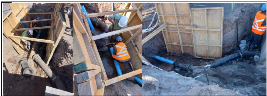
Fuente: Empresa CCZ Ingeniería, tomada en terreno en la comuna de San Esteban, [2022].
