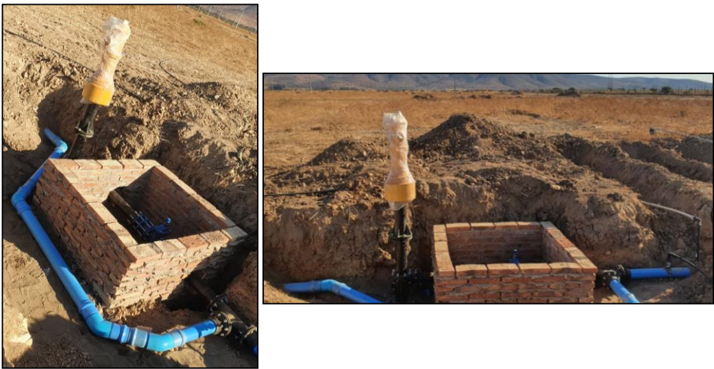
Fuente: Empresa CCZ Ingeniería, tomada en terreno en la comuna de San Esteban, [202-].
