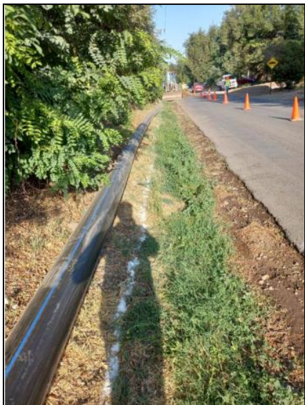
Figura 3-3. Trazado para comienzo de excavaciones.
