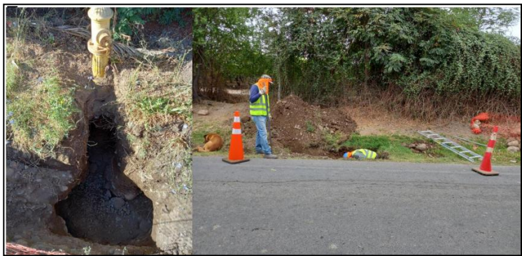
Figura 3-2. Calicata exploratoria para identificar red de agua potable existente.
