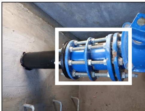
Figura 1-6. Unión autobloqueante.
