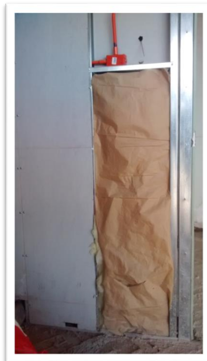
Figura 2-10: Construcción muro interior
