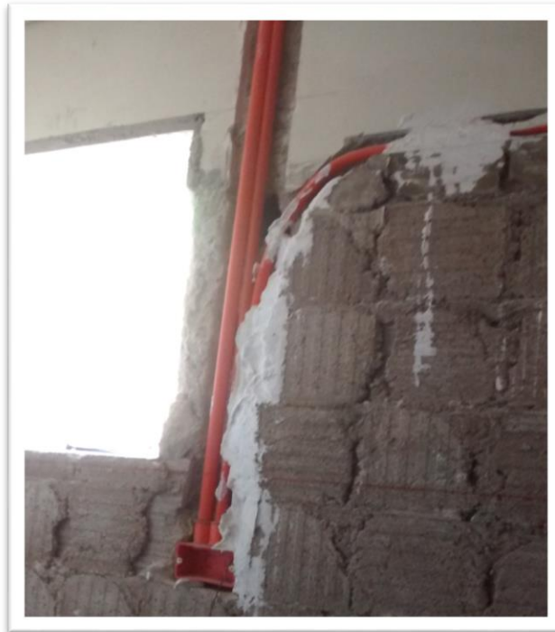
Figura 2-19: Colocación instalación eléctrica en el baño
