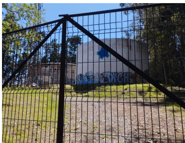
Figura 7:Urbanización Aledaña Laguna Grande San Pedro De La Paz. (Elaboración Propia)
