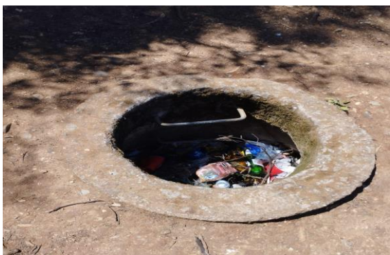
Figura 3: Basura En Alcantarillado. (Elaboración Propia)
