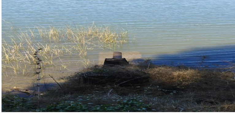
Figura 5: Tubo Aguas Servidas. (Elaboración Propia)
