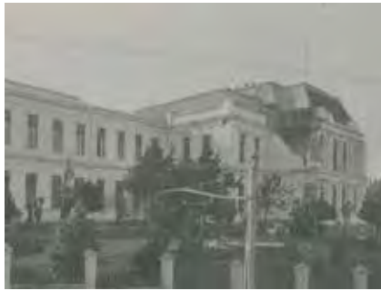
Fig. 70 Daños ocasionados en la Escuela Naval tras el terremoto de 1906 |Fuente: Biblioteca Histórica de la Armada y Museo Marítimo Nacional
