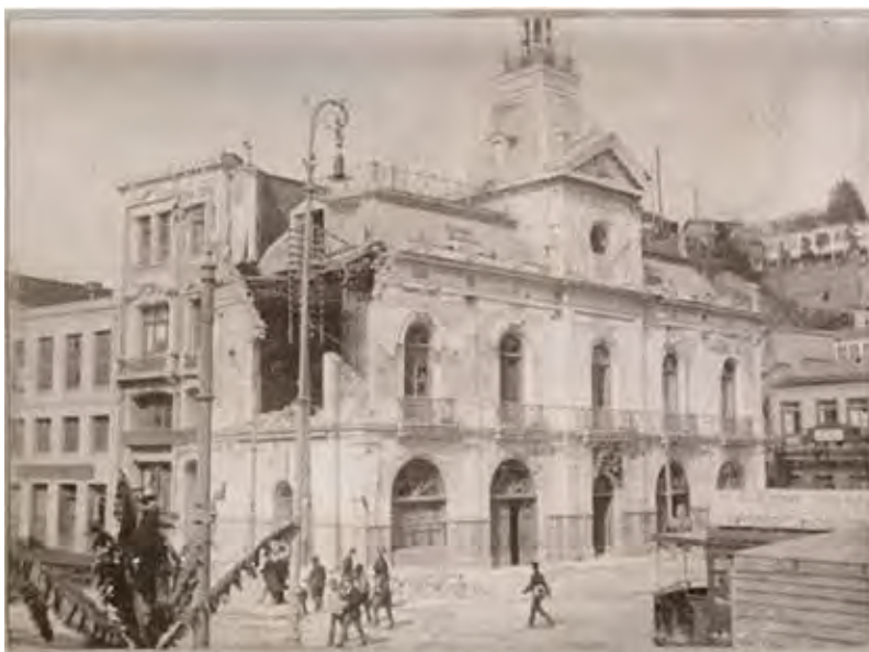
Fig. 51 Edificio del Cuartel de Bomberos posterior a 1906 |Fuente: www.fotografiapatrimonial.cl
