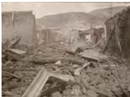
Fig. 4 Escombros sobre la calle Almirante Barroso [Fotografía, Terremoto de 1906, autor no identificado, N° de inventario AF 73-106, Colección Museo Histórico Nacional.
