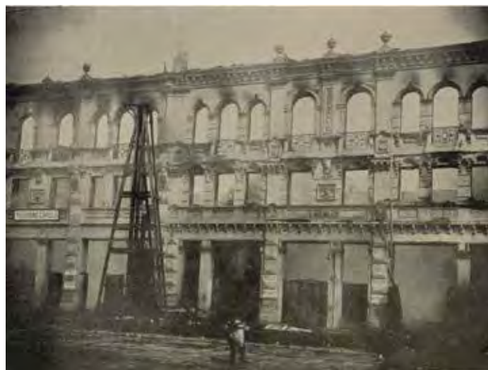
Fachada de edificio en pie con el interior quemado
