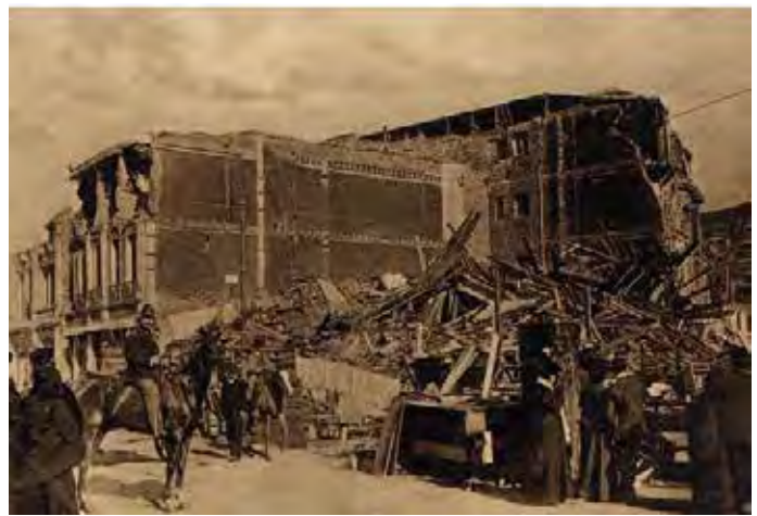
Esquina Puente Jaime
