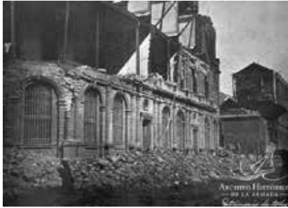
Fig. 24 Caída de los muros de fachada del segundo y tercer piso del Colegio de los S.S.C.C |Fuente: Archivo Histórico de la Armada
