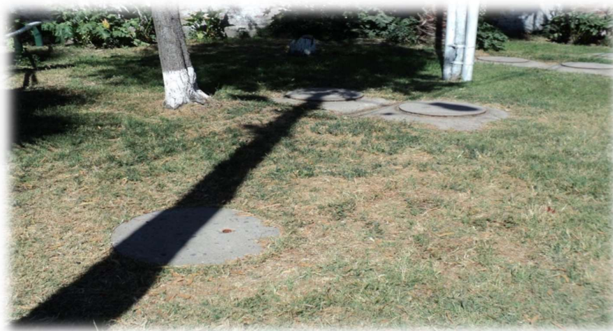
Ilustración 20: Conductos de Inspección Fosa Séptica Población el Carmen.
