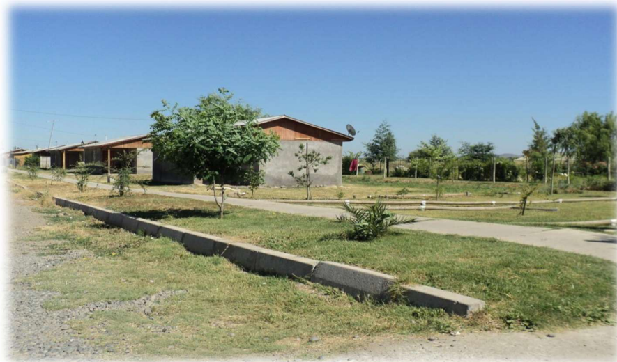
Ilustración 11: Viviendas con Solución Particular de Alcantarillado (Fotografía Referencial).
