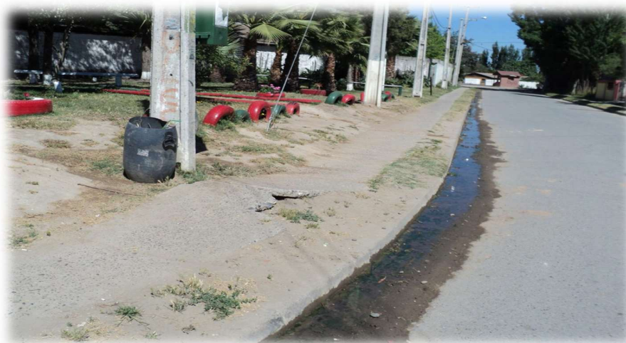
Ilustración 21: Aguas Residuales Expulsadas a la Calle.
