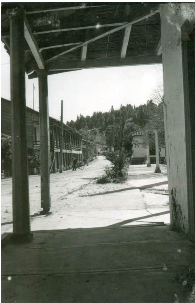
B6. Fotografía histórica vista desde corredores a edificio municipal y plaza de armas.
