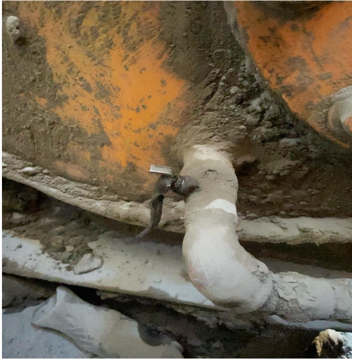
Figura 3-15: Llave en la parte inferior del estanque
