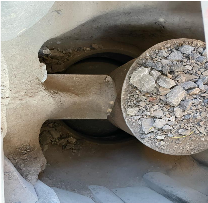
Figura 3-9: Cámara de chancador en condiciones de puesta en servicio.
