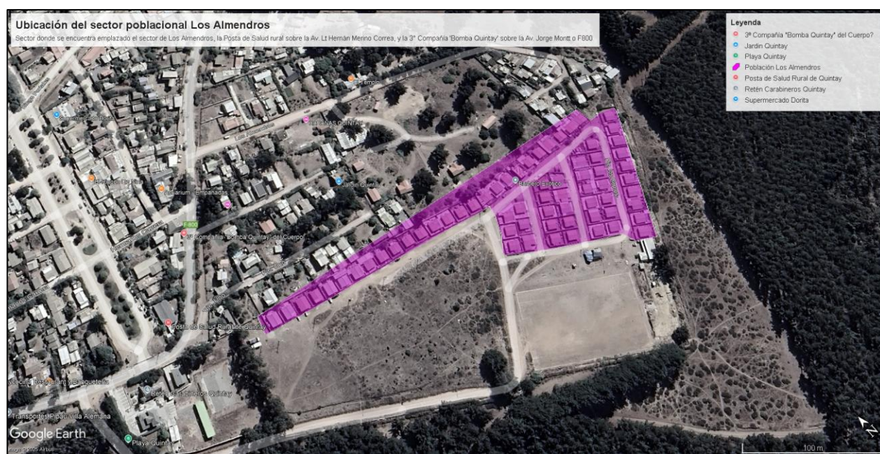
Figura I-2. Ubicación del sector poblacional Los Almendros, en Quintay, donde se aprecia la Avenida Teniente Hernán Merino Correa, calle principal del pueblo. Elaboración propia.
