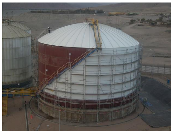
Estanque techo tipo domo.
