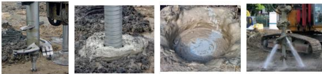
Figura 2.5. Ejecución de una columna de DSM por el método húmedo. (Fuente: Ref. [26]).
