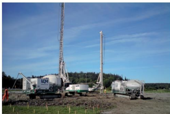
Figura 2.10. Equipos móviles para ejecutar DSM vía seca. (Fuente: Ref. [26]).
