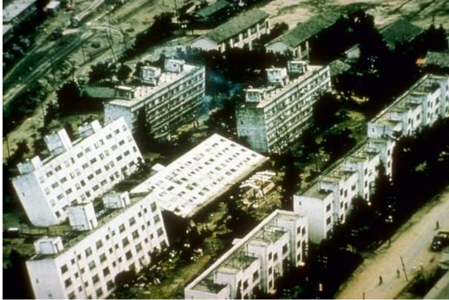
Figura 4.1. Efectos de la Licuefacción de Suelos, Terremoto Niigata, Japón, 1964. (Fuente: Wikipedia)
