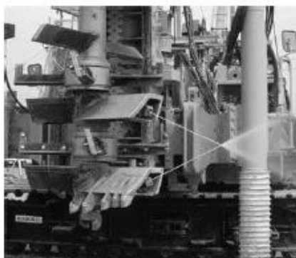
Figura 2.1. Sistema híbrido mecánico e inyección a alta presión. (Fuente: Ref. [1]).
