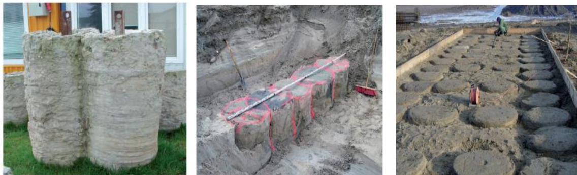
Figura 2.14. Columnas de DSM expuestas. (Fuente: Ref. [26]).
