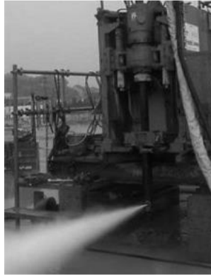
Figura 2.2. Inyección a alta presión. (Fuente: Ref. [1]).
