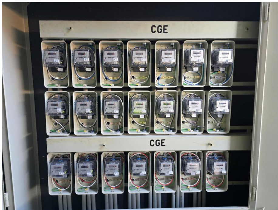
Ilustración 1-2 Parrilla de medidores, Fuente: Elaboración propia.
