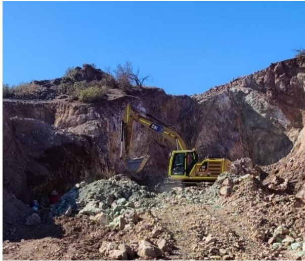
Figura 3-1. Imagen ilustrativa de excavadora retirando material.
