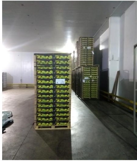
Fuente: Cefrupal Figura 1-28. Cámara frigorífica 2
