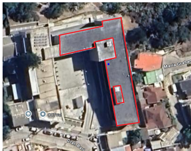
Figura 4.9: Azotea edificio AC3E.
