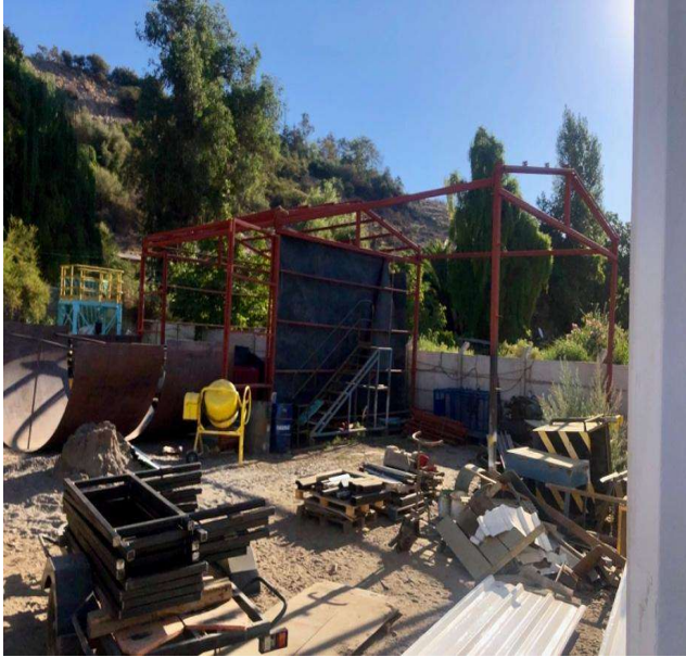
Figura 2.15 Sector de acopio trabajos terminados
