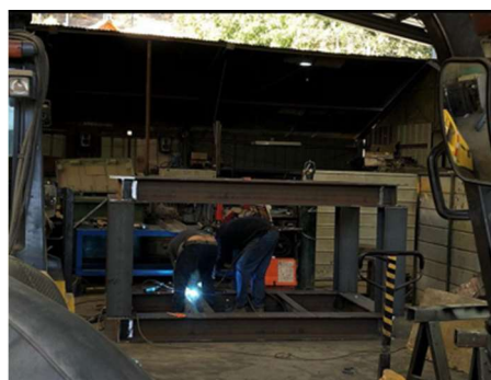
Figura 2.14 Trabajos en soldadura a gasa estructuras
