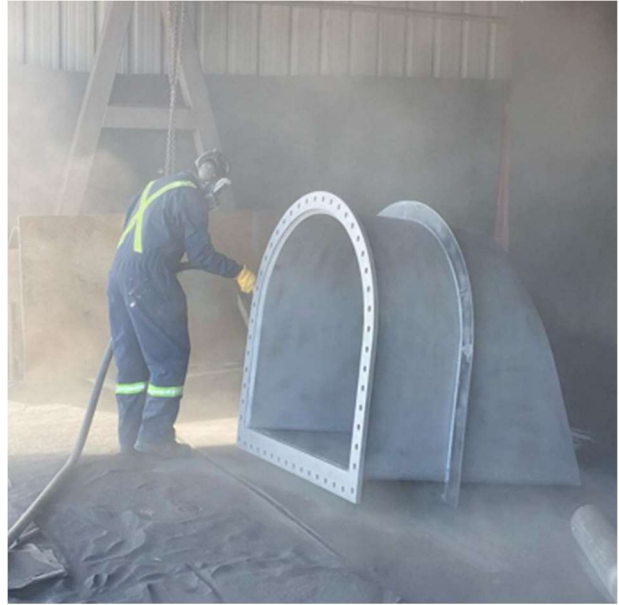
Figura 2.16 Proceso de pintado a estructuras terminadas.
