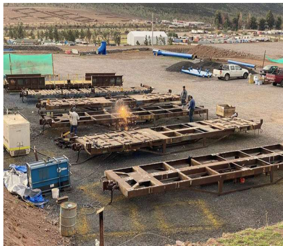
Figura 2.20 Reparación a remolques de camiones, sector Vilcuya Fuente M&N Mining
