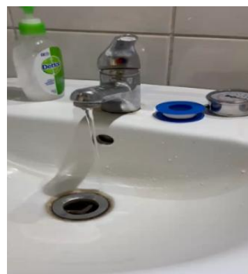
Fig. 1.1 Evidencia de bajo caudal (0,3 L/min).
