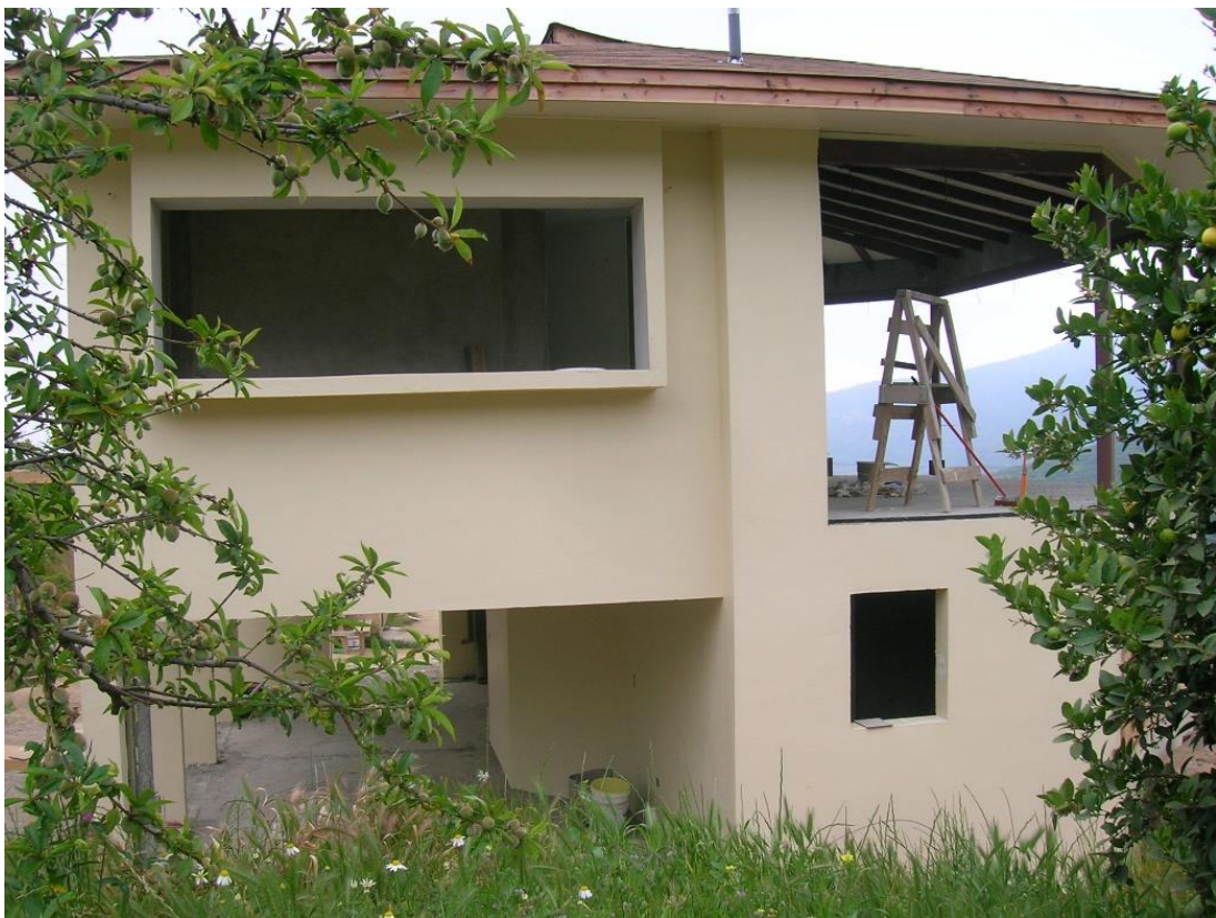
Figura 2-4. Avance trabajos de pintura, Vista Oeste.
