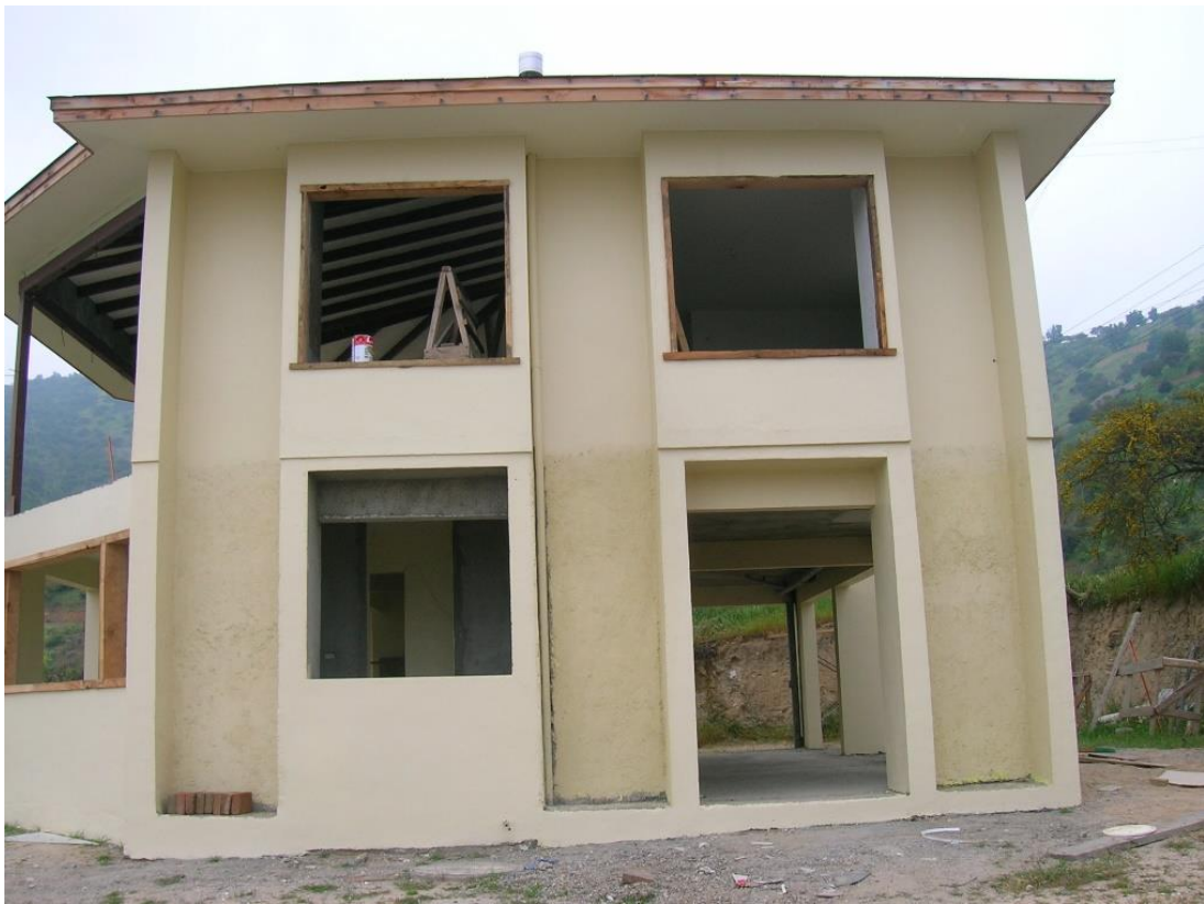
Figura 2-5. Avance trabajos de pintura, Vista Este.
