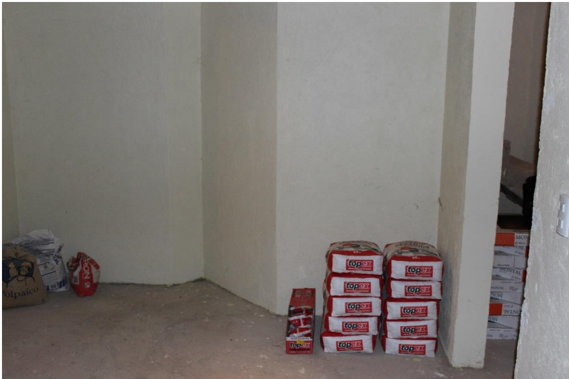
Figura 2-8. Muros después de pintar.
