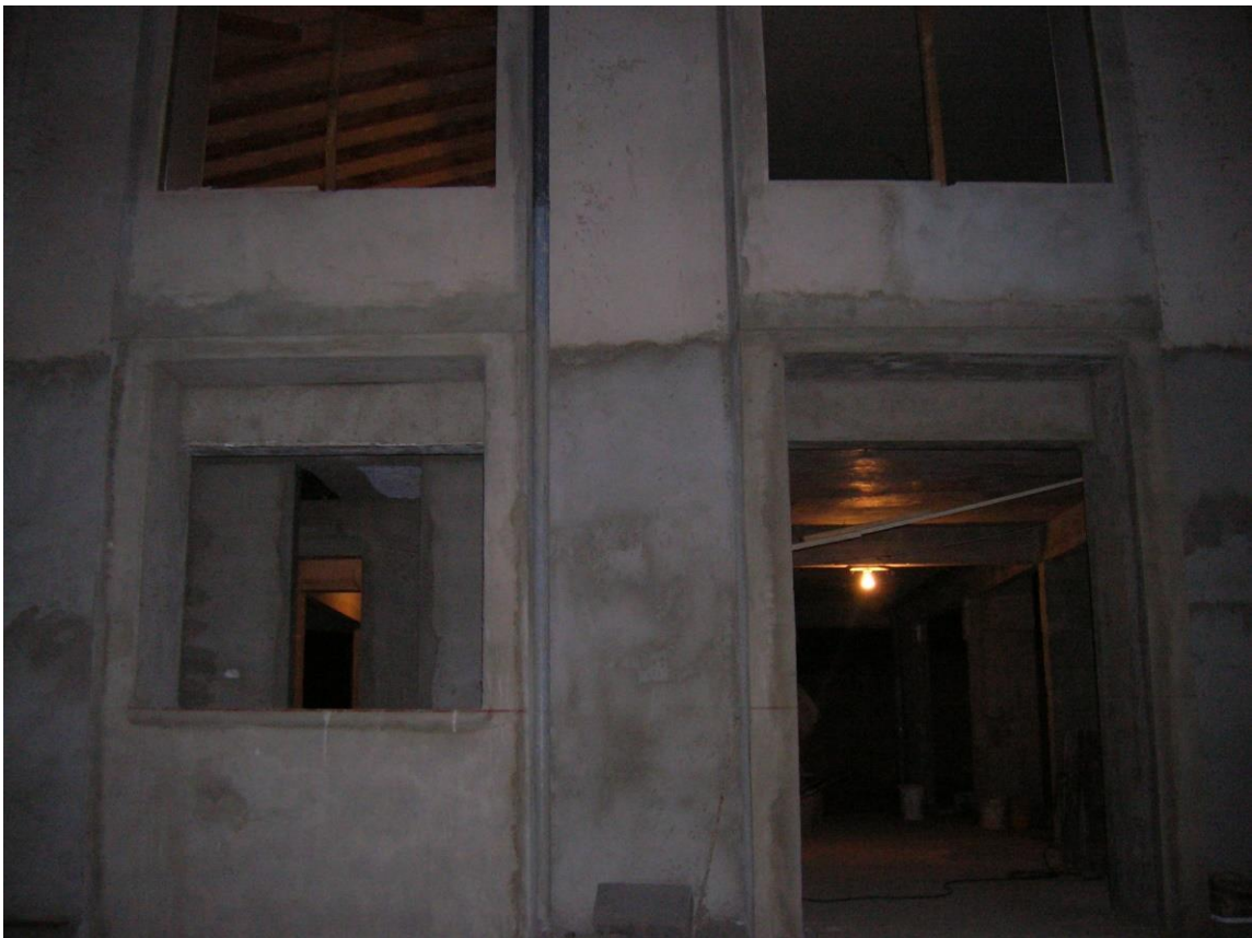
Figura 2-2. Avance trabajos de estucado, Vista Este.
