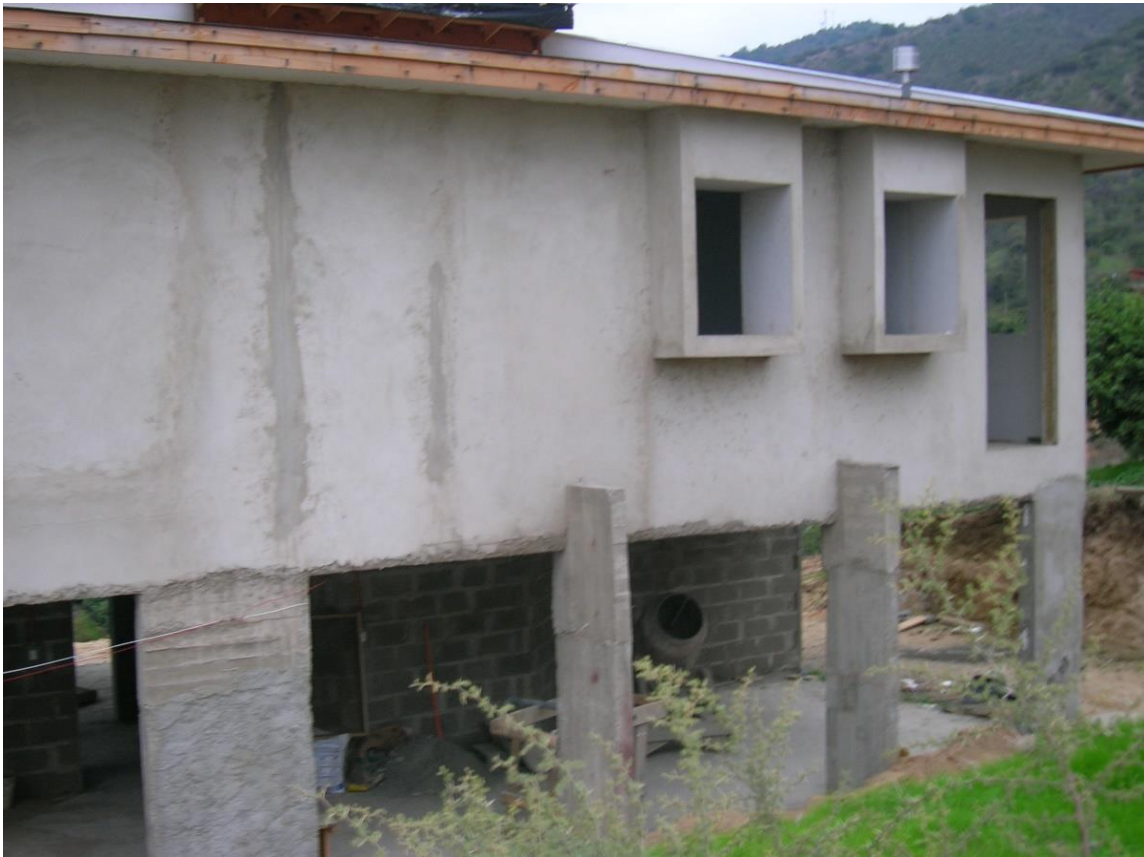
Figura 2-1. Avance trabajos de estucado, Vista Norte.
