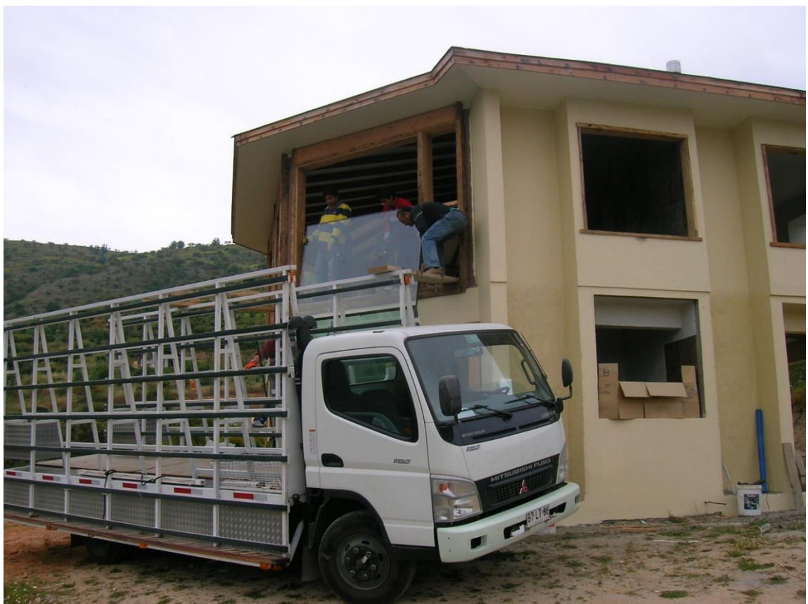
Figura 2-12. Instalación ventanas.
