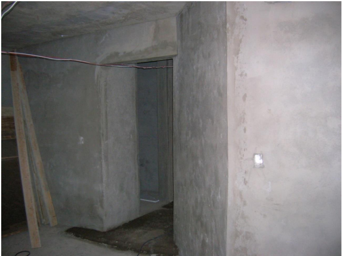
Figura 2-7. Muros antes de pintar.
