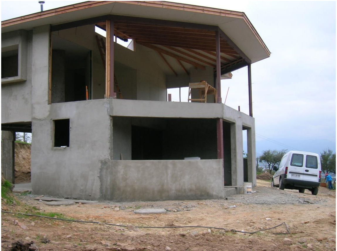
Figura 2-3. Avance trabajos de estucado, Vista Suroeste.
