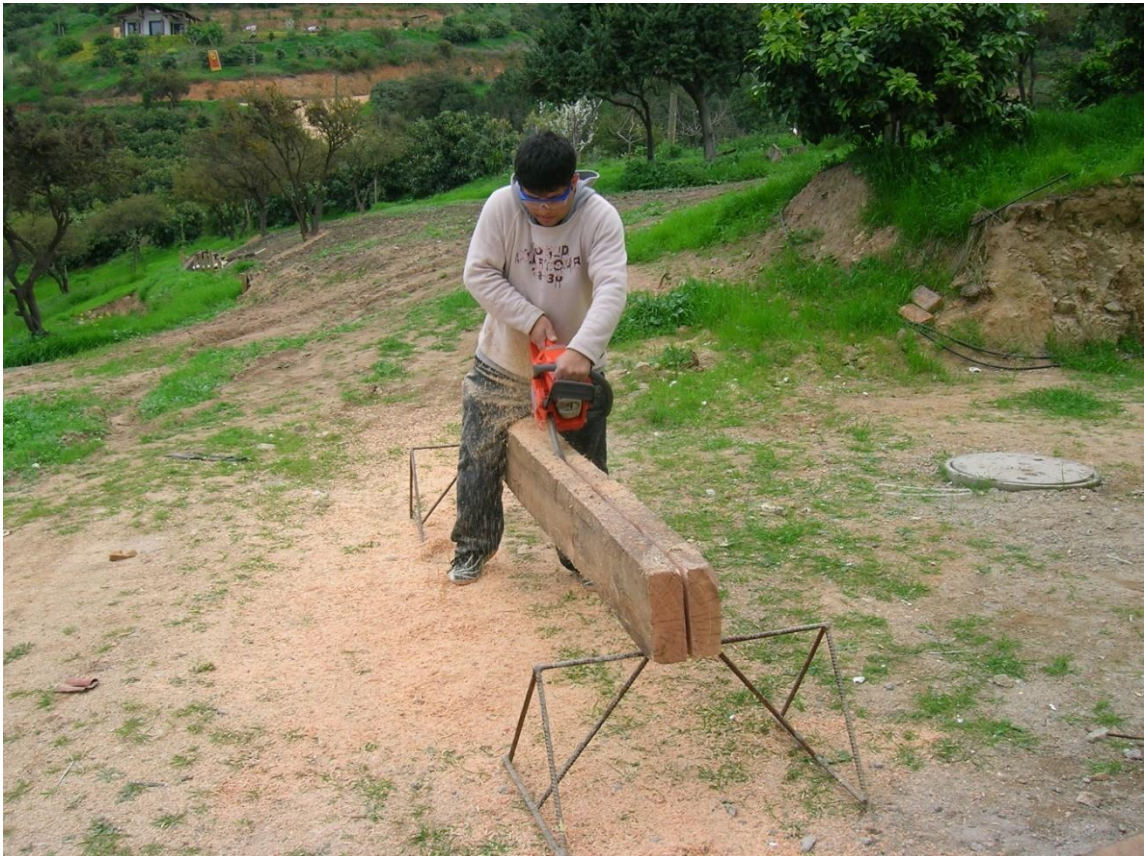
Figura 2-10. Corte a lo largo de los durmientes.
