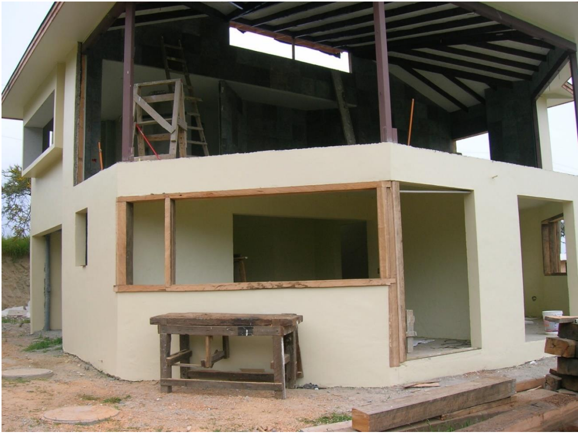
Figura 2-11. Marcos instalados.
