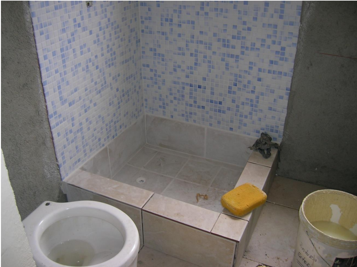
Figura 2-15. Avance cerámica baño 1.
