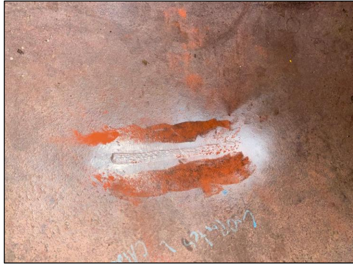
Figura 1. 3: Reparación de grieta en equipo acumulador de vapor.
