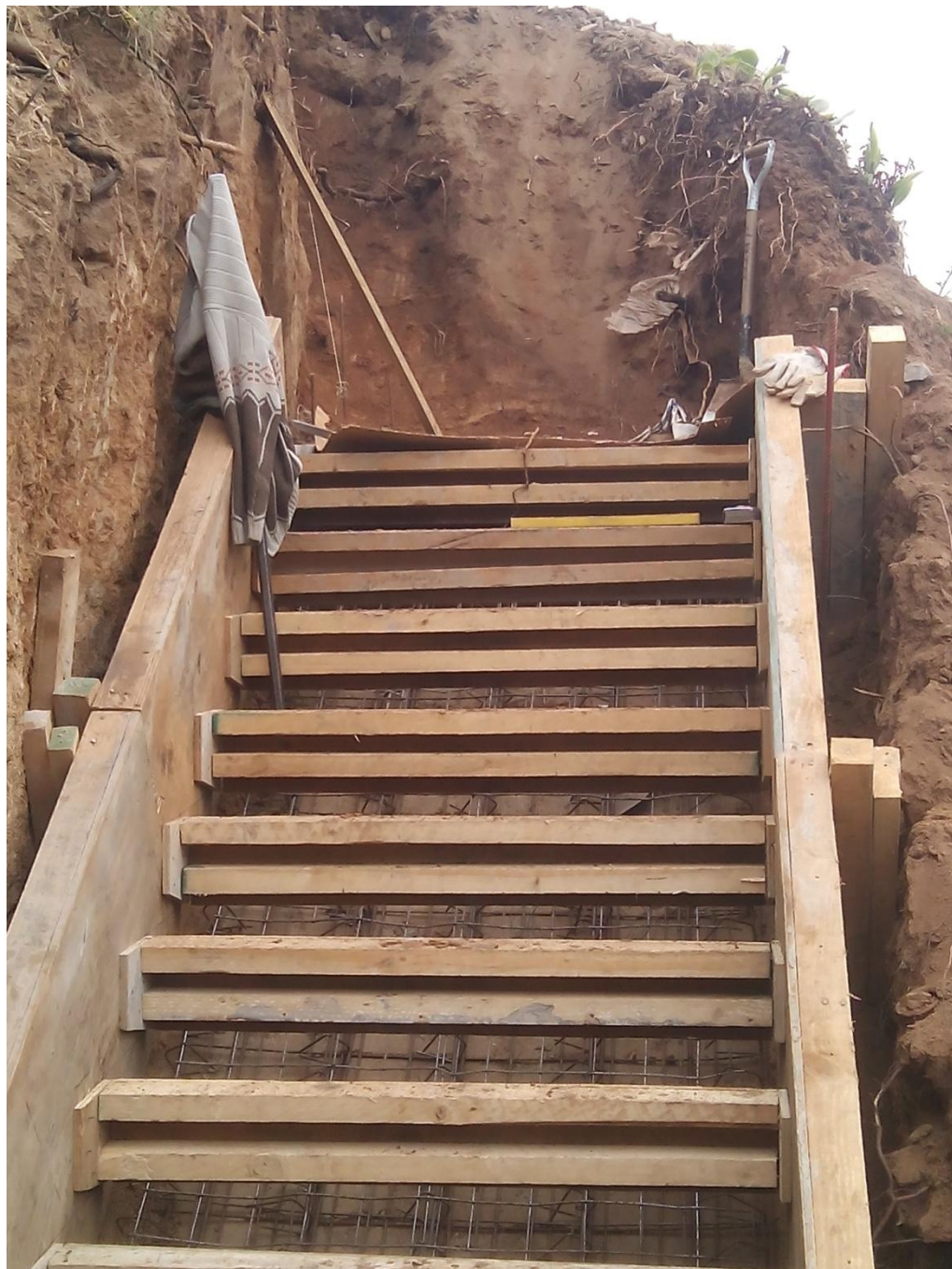
Figura 2-10. Moldaje Escalera de Hormigón Armado, TD N°88-2016
