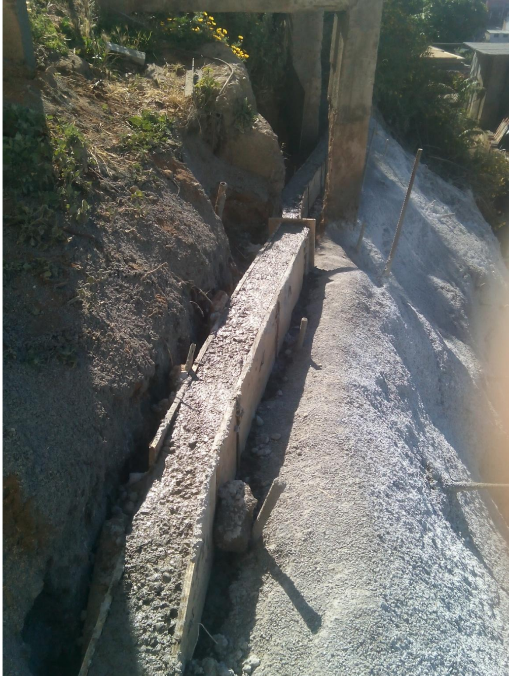
Figura 2-21. Viga auto soportante hormigonada, TD N°88-2016
