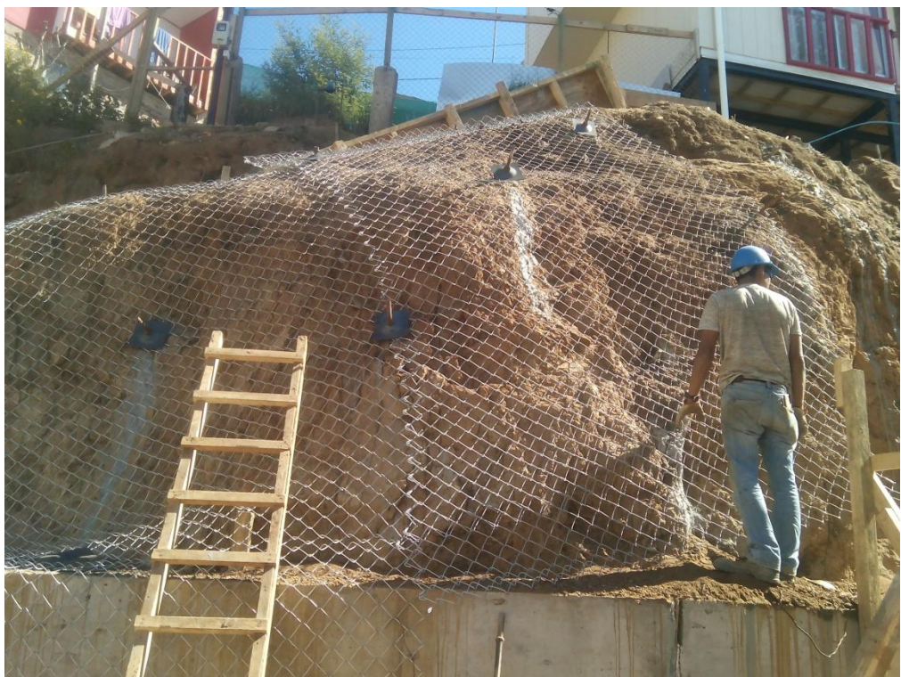
Figura 2-18. Instalación de malla MFI3500-75 shotcrete, TD N°88-2016
