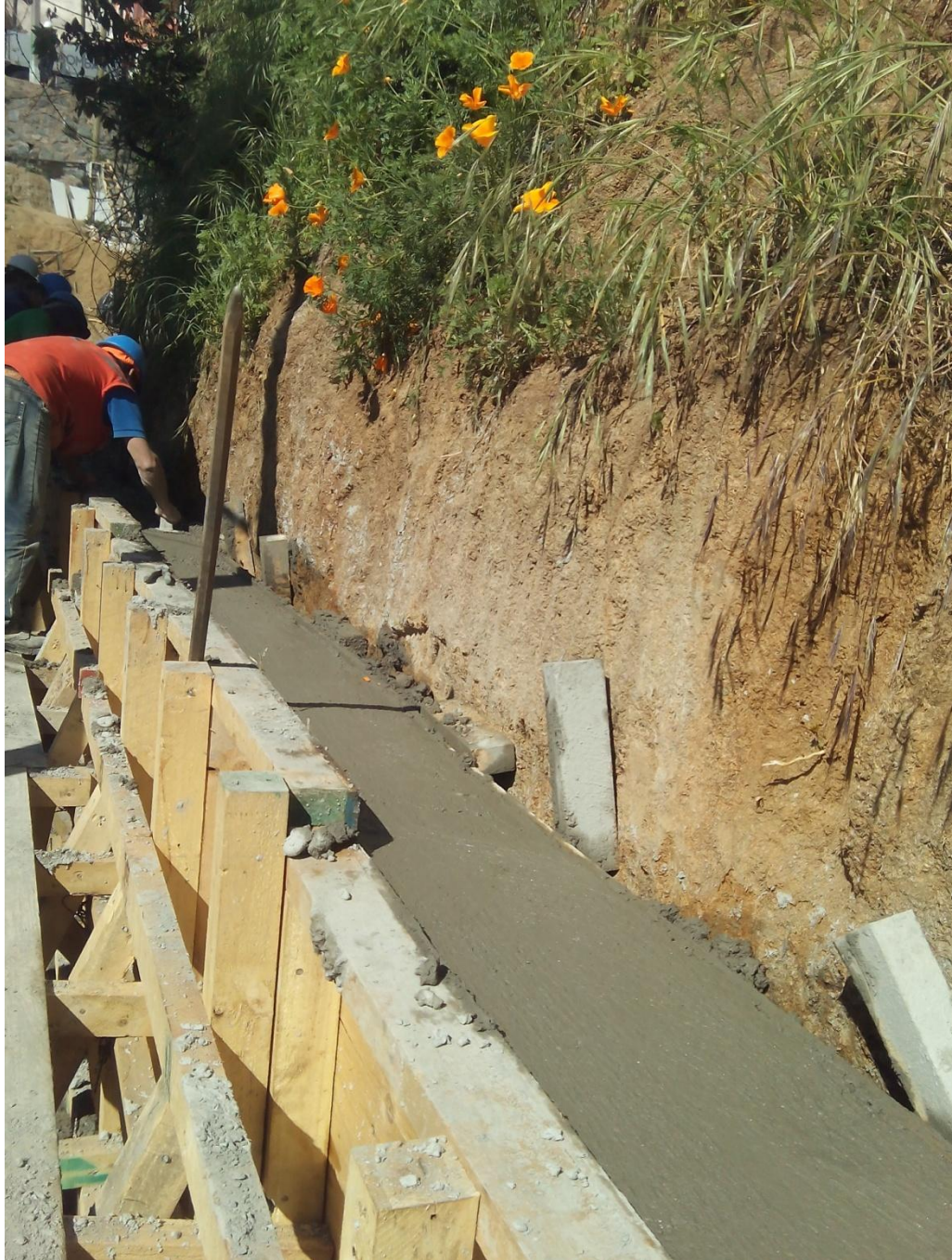
Figura 2-7. Platachado y remate paramento Muro Tipo 1, TD N°88-2016
