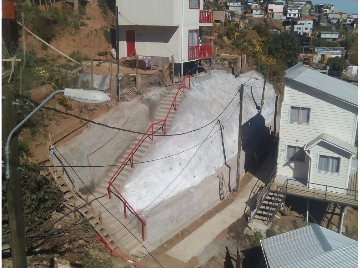
Figura 1-33. Obra Pasaje interior Los Castaños terminada, TD N°88-2016
