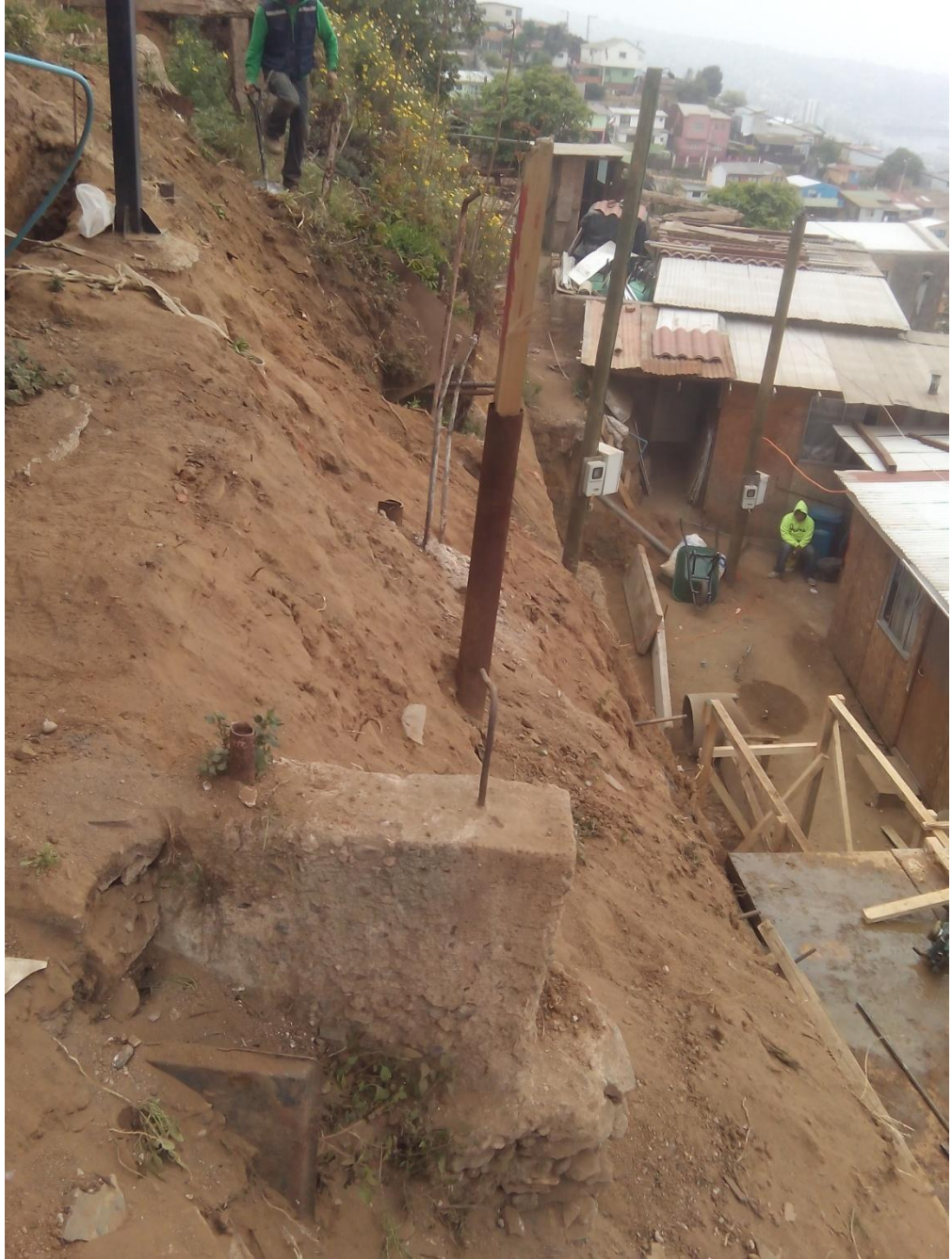
Figura 2-13. Limpieza y perfilado terreno zona shotcrete, TD N°88-2016
