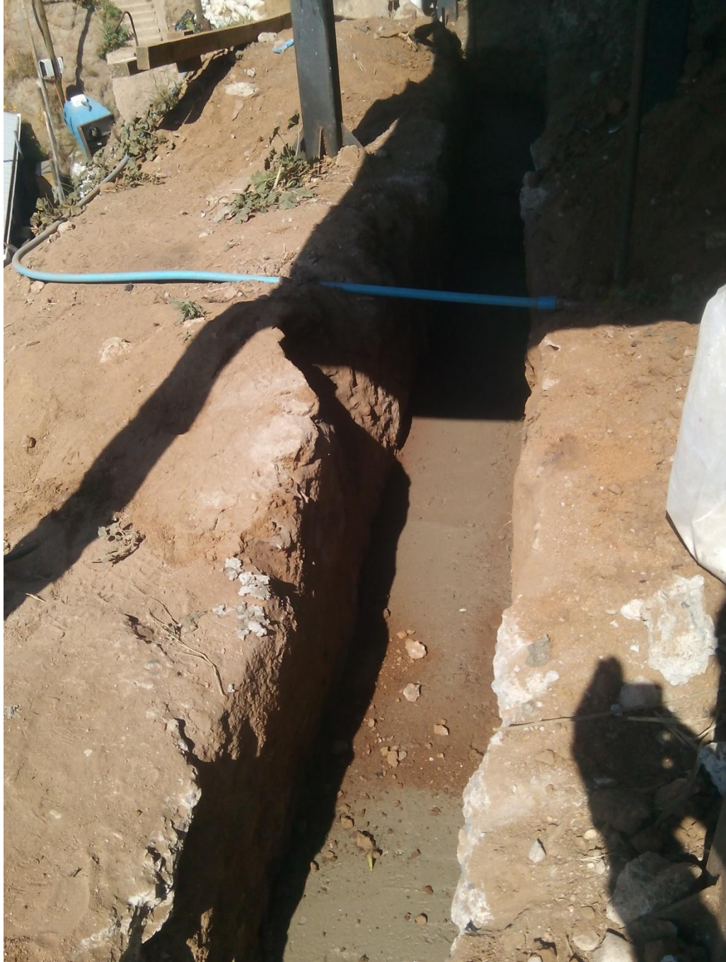
Figura 2-16. Emplantillado de viga autosoportante shotcrete, TD N°88-2016
