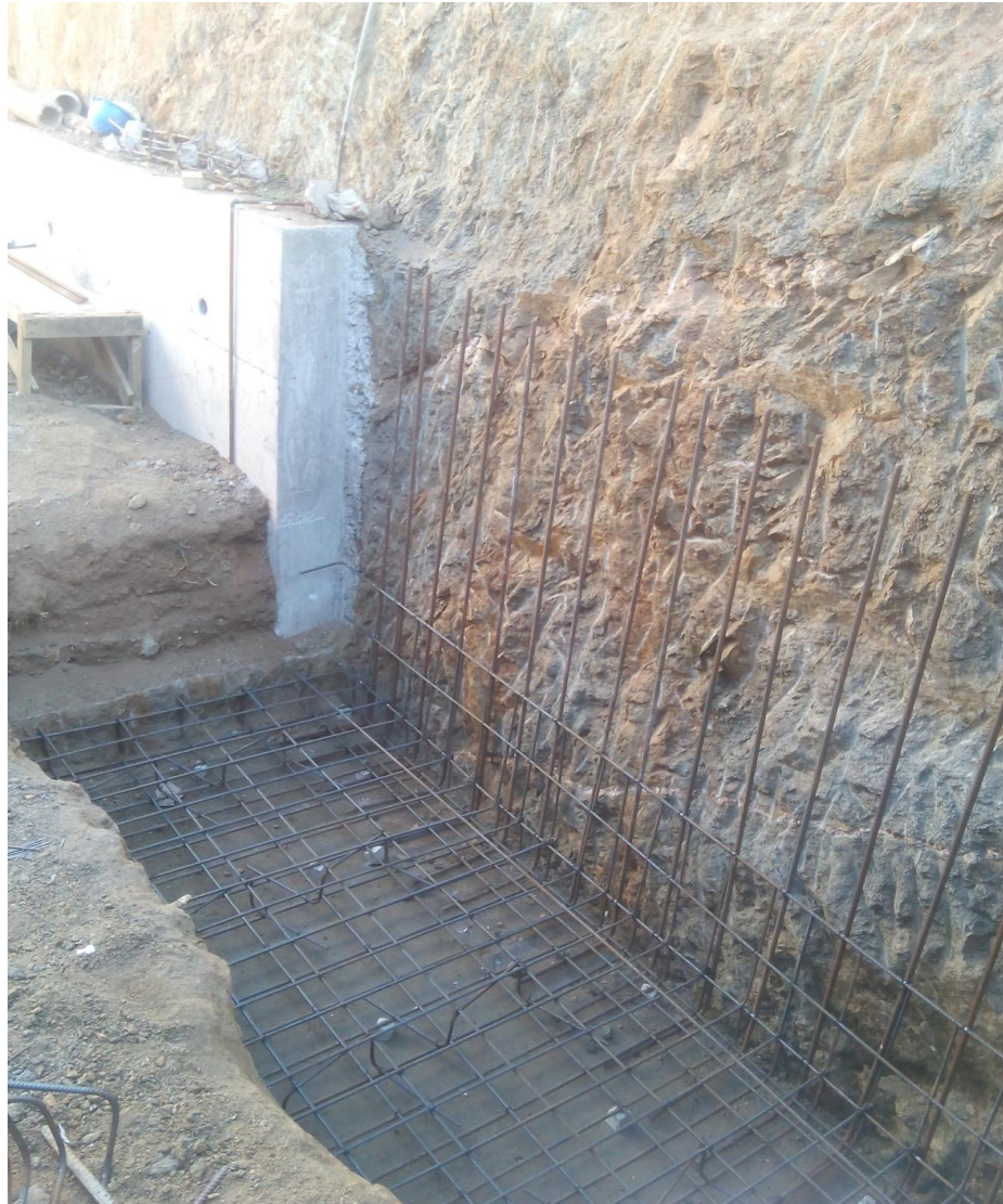
Figura 2-1. Enfierradura zapata Muro Tipo 1, TD N°88-2016
