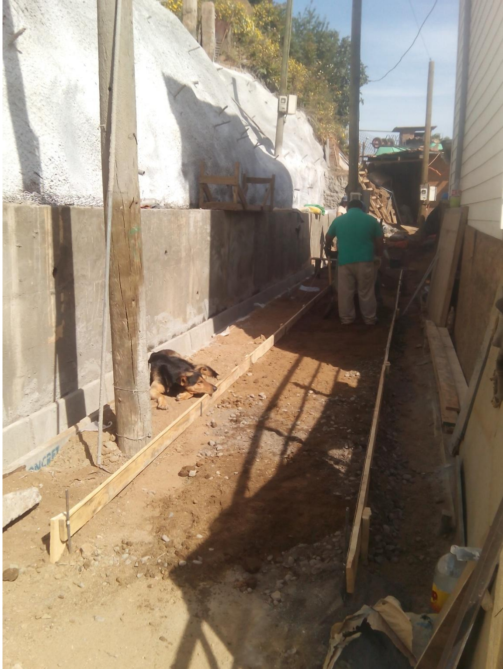
Figura 2-24. Preparación subrasante Acera proyectada, TD N°88-2016
