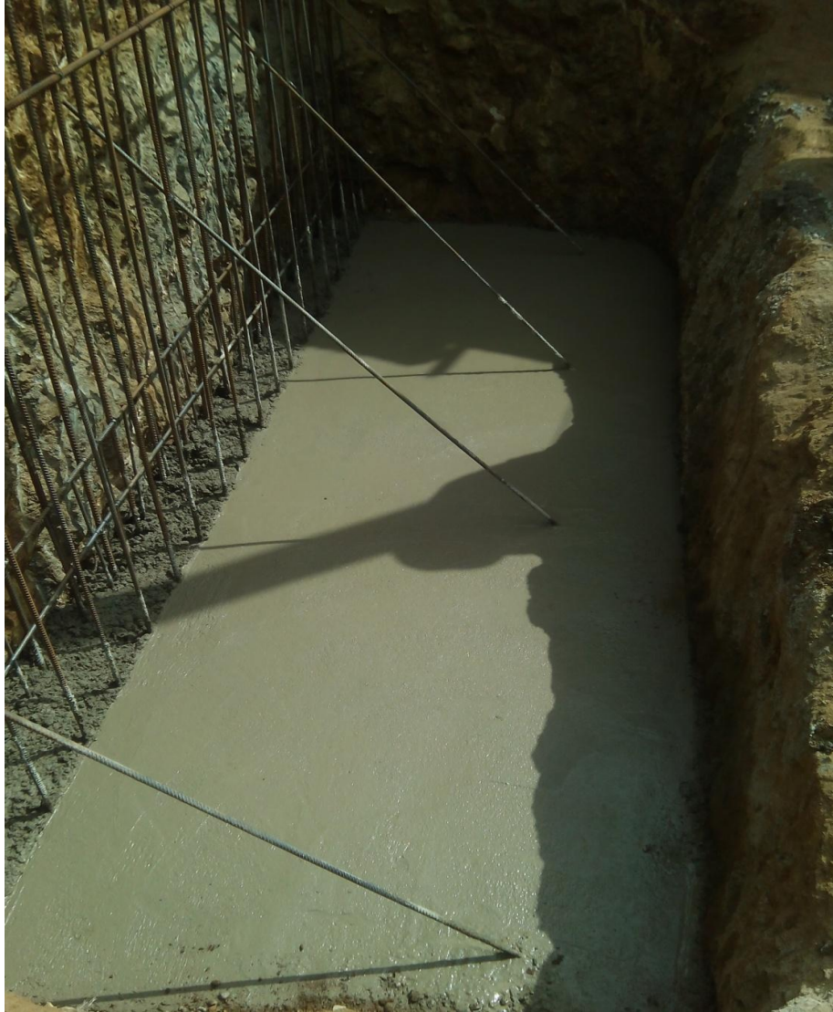
Figura 2-2. Hormigonado zapata Muro Tipo 1, TD N°88-2016
