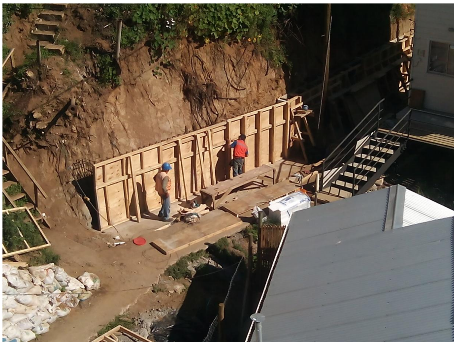
Figura 2-4. Moldaje Paramento Muro Tipo 1, TD N°88-2016
