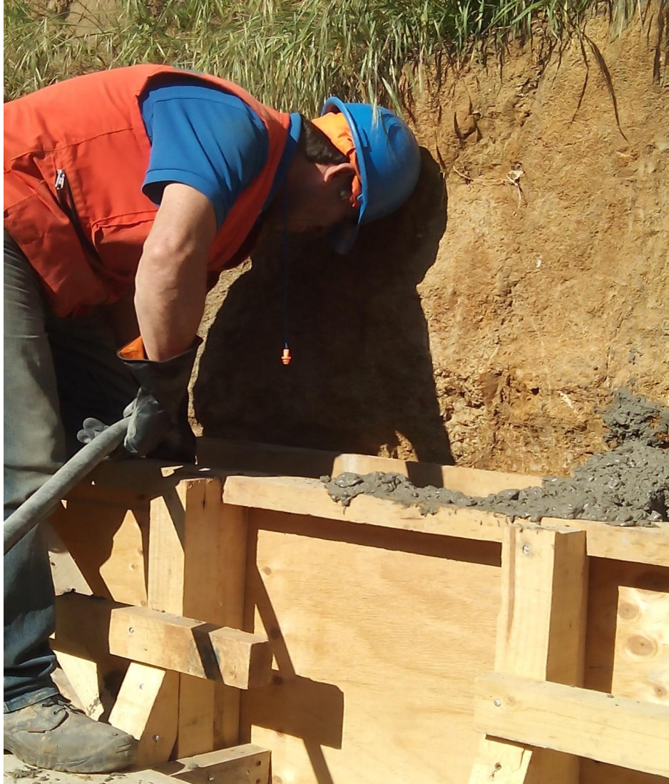
Figura 2-6. Vibrado del hormigón paramento Muro Tipo 1, TD N°88-2016
