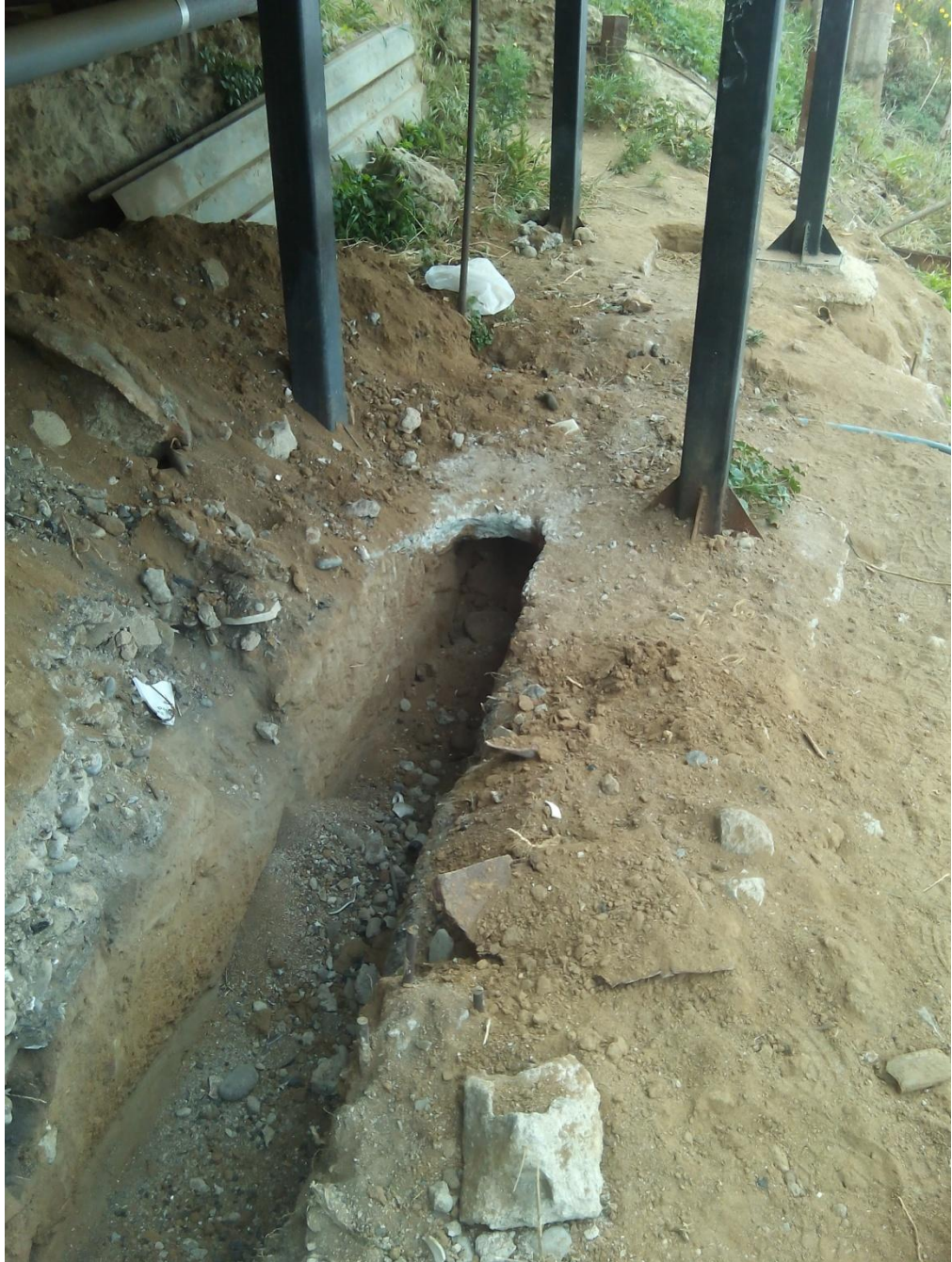
Figura 2-15. Excavación de viga autosoportante shotcrete, TD N°88-2016
