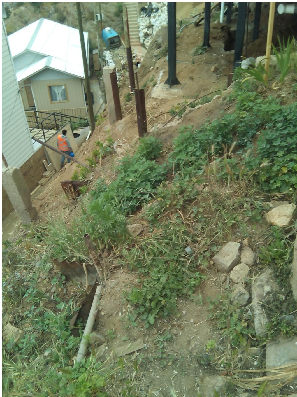
Figura 2-12. Terreno natural zona shotcrete, TD N°88-2016
