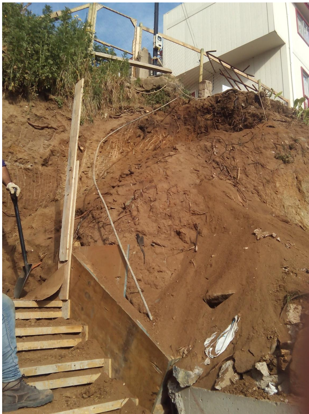
Figura 2-8. Movimiento de tierra Escalera de Hormigón Armado, TD N°88-2016
