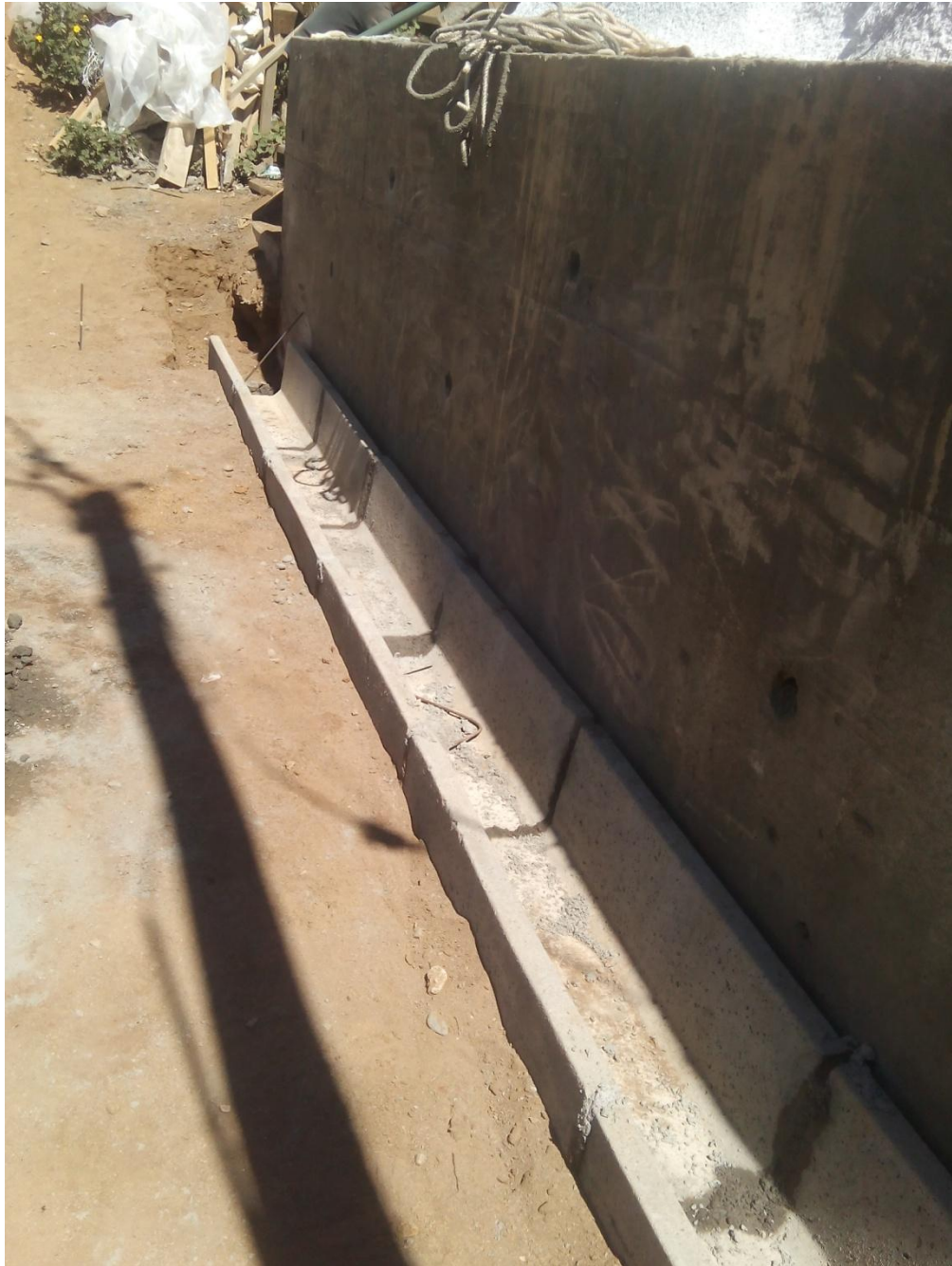
Figura 2-23. Instalación canaletas prefabricadas, TD N°88-2016
