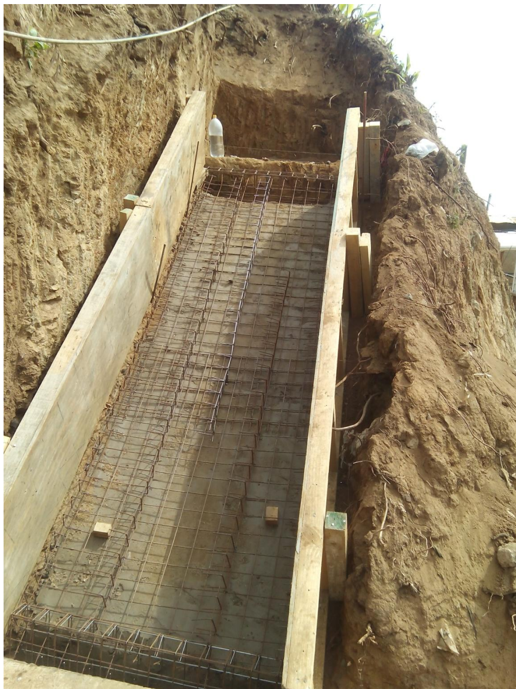
Figura 2-9. Enfierradura Escalera de Hormigón Armado, TD N°88-2016
