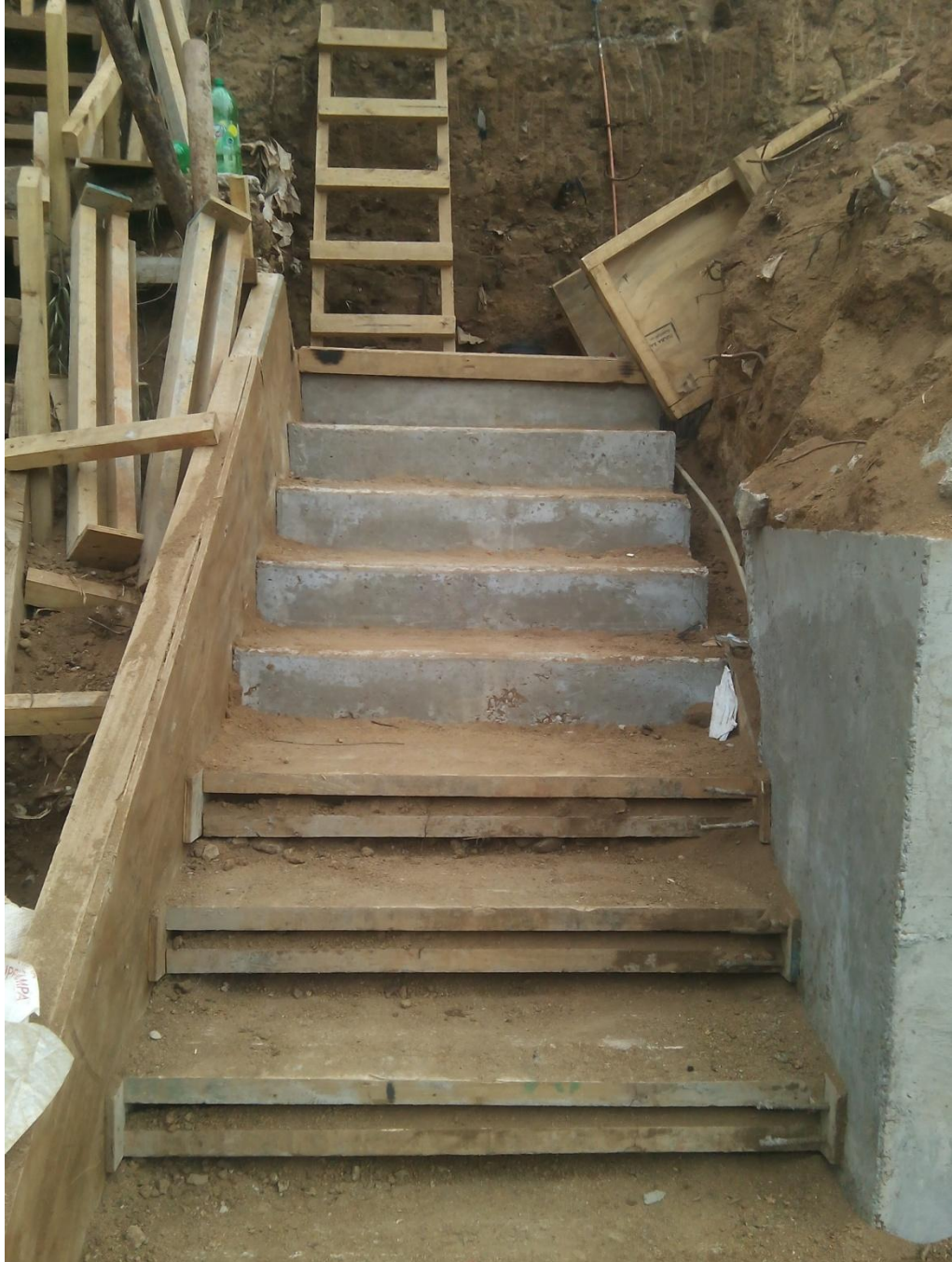
Figura 2-11. Escalera de Hormigón Armado, TD N°88-2016
