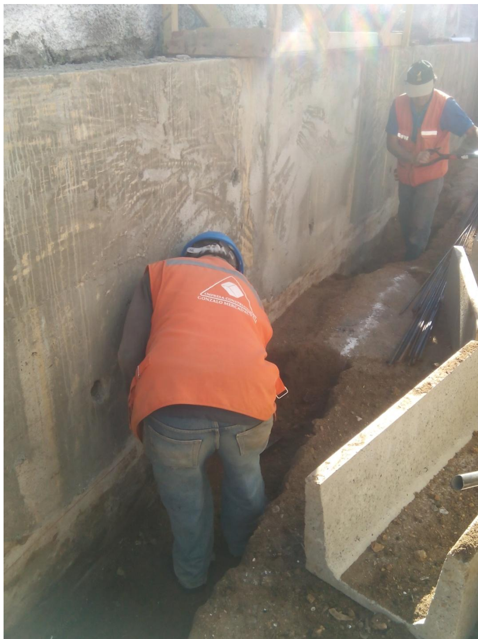
Figura 2-22. Excavación canaletas prefabricadas, TD N°88-2016
