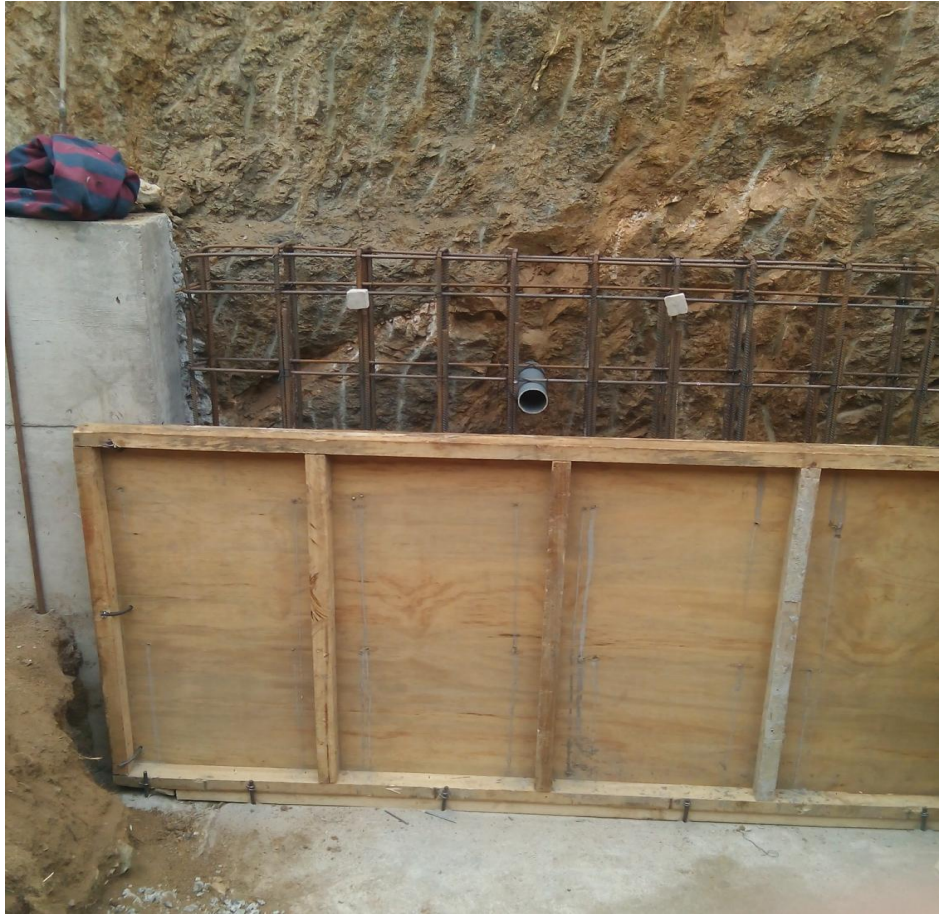
Figura 2-3. Barbacana y moldaje paramento Muro Tipo 1, TD N°88-2016
