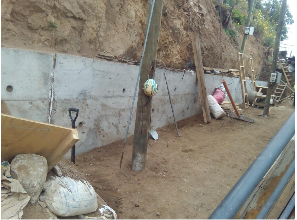
Figura 2-31. Escombros en la obra, TD N°88-2016
