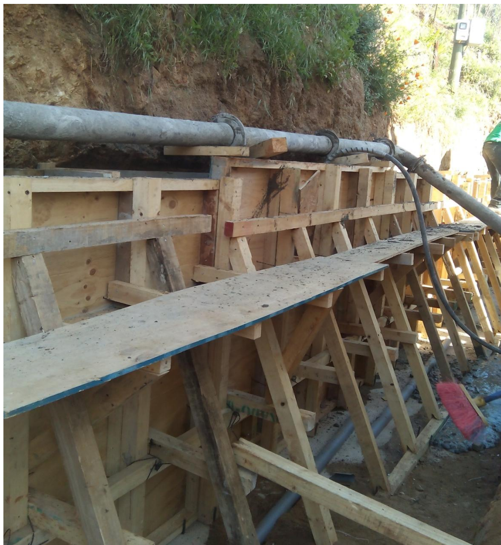
Figura 2-5. Hormigonado paramento Muro Tipo 1, TD N°88-2016
