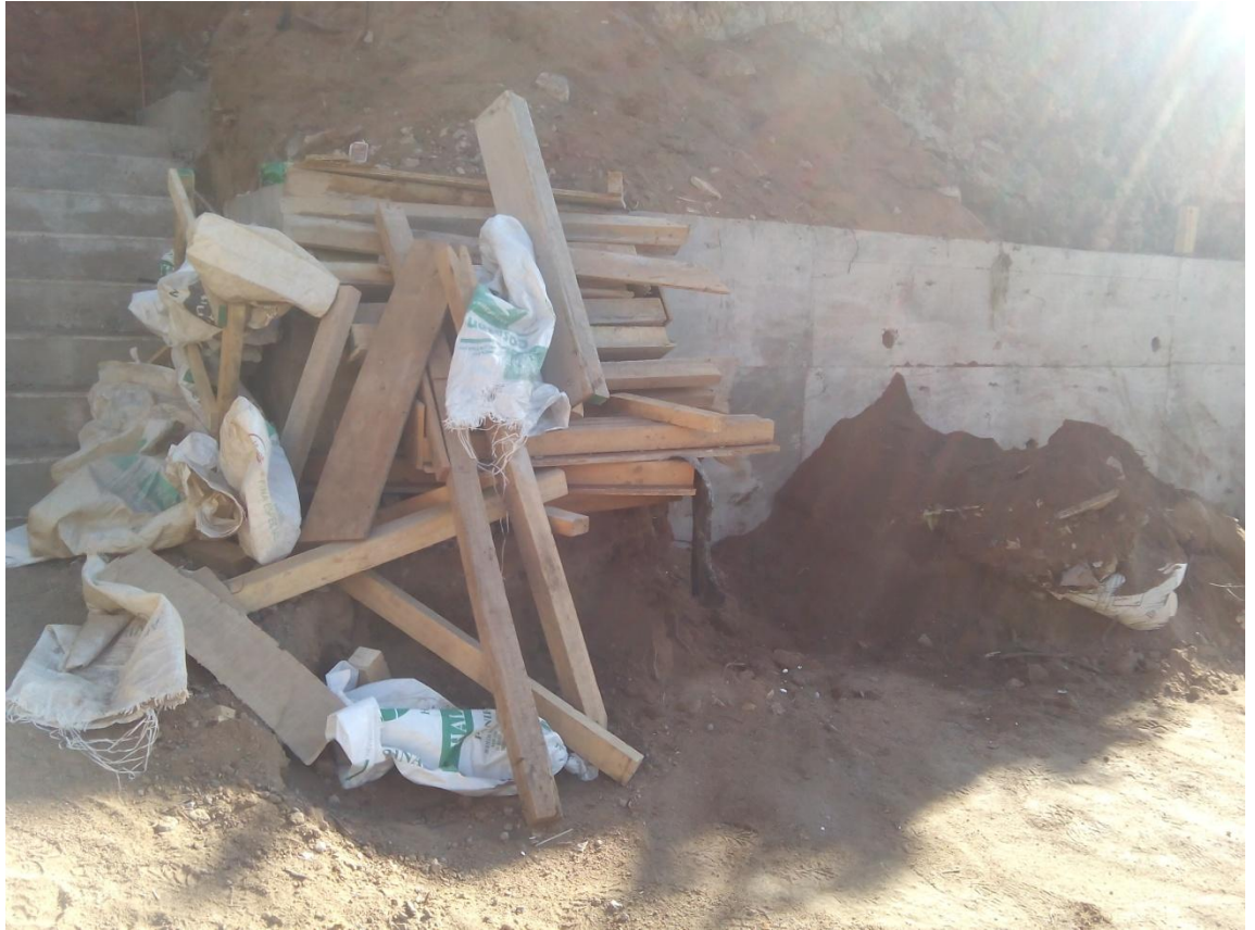
Figura 2-30. Escombros en la obra, TD N°88-2016
