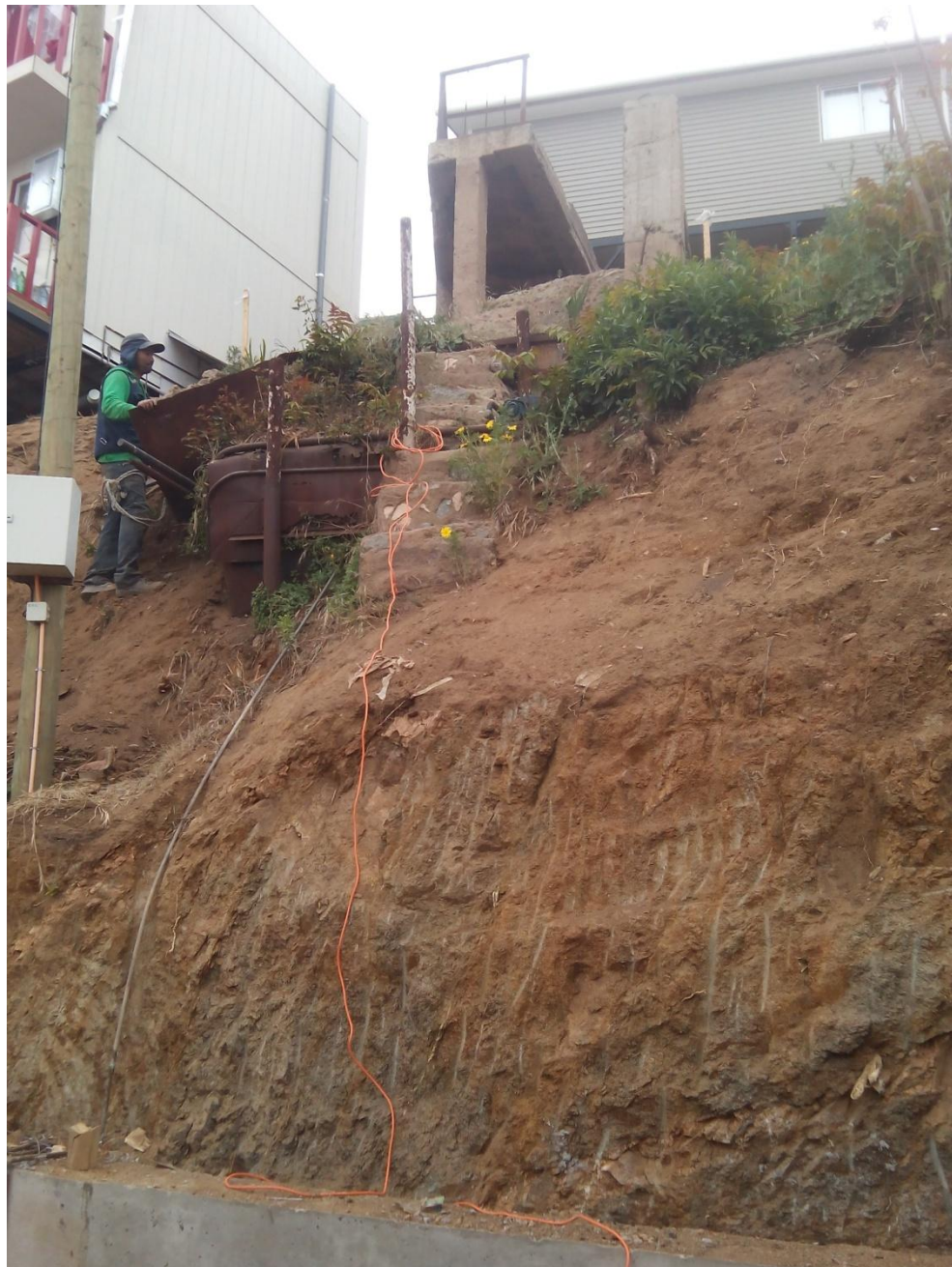
Figura 2-14. Limpieza y perfilado terreno zona shotcrete, TD N°88-2016
