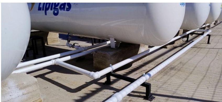
Figura 83: Instalación tipo Peineta
