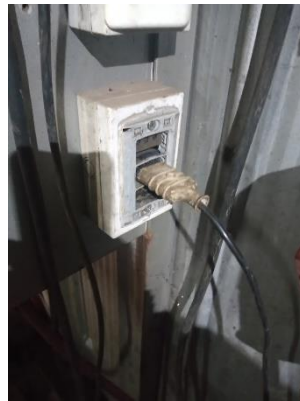
Imagen 2: Condiciones inseguras presentes en el sector de mecanizado, pilar inestable, conexión a la corriente eléctrica en mal estado, y pobre iluminación.
