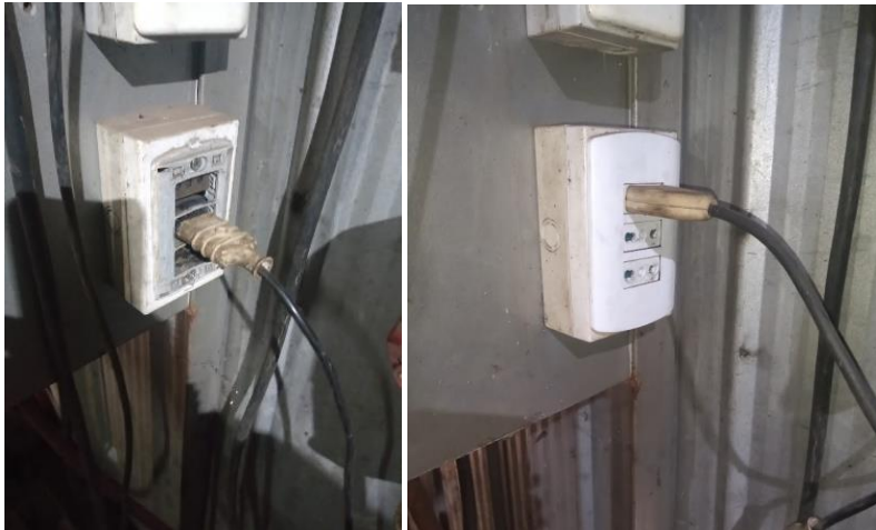
Respaldo visual N°38: Reemplazo de enchufe de la maestranza.
