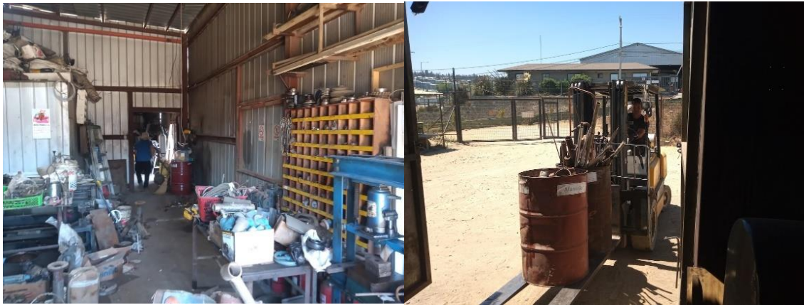
Respaldo visual N°11: avance en la extracción de los mobiliarios de manera manual y asistido con maquinaria.
