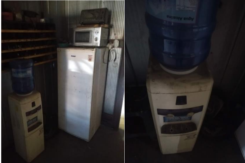
Imagen 7: Estado inicial de la cocina y sus elementos relacionados, refrigerador, dispensador de agua y microondas en entre la zona de mecanizado y soldadura, cocina no transitable.
