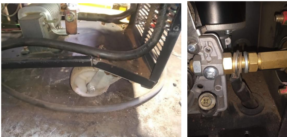
Respaldo visual N°63: Falla en la estructura de la máquina de soldar y registro del orden de ensamblaje de la guía de aporte.
