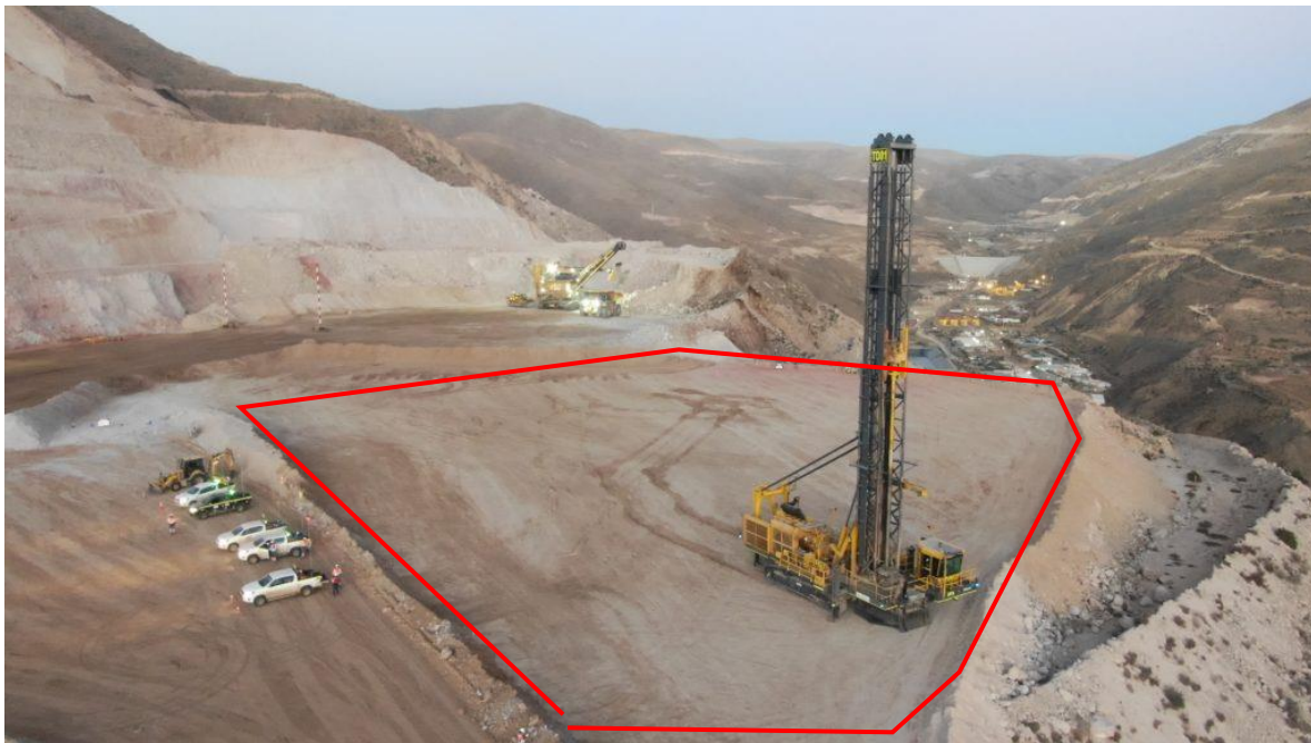
Figura 16. Geocerca en proceso de perforación autónoma.
