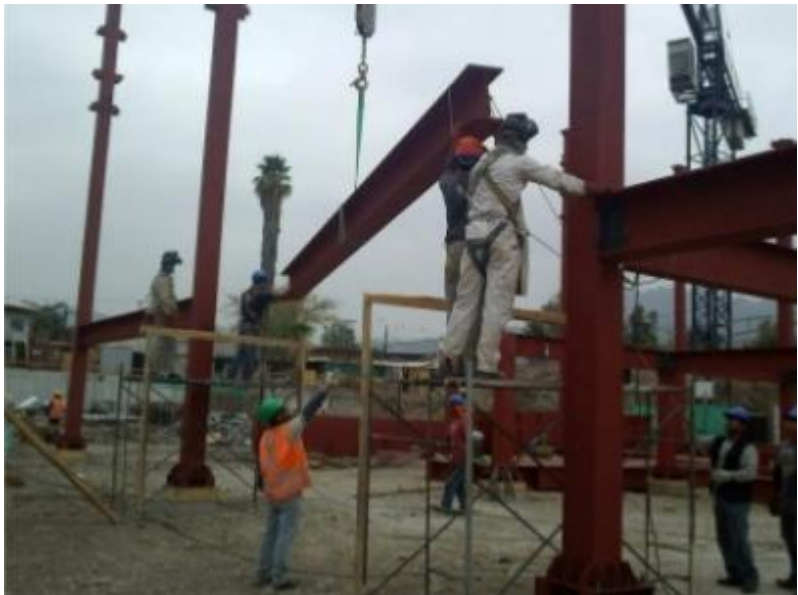
Figura 2-16 Montaje de obra.
