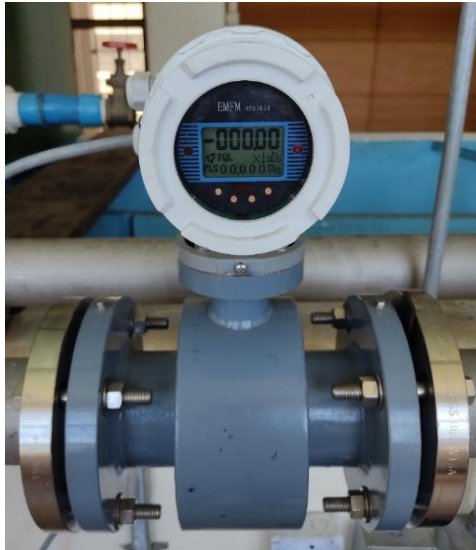
Figura N°17: Flujómetro electromagnético DN80.
