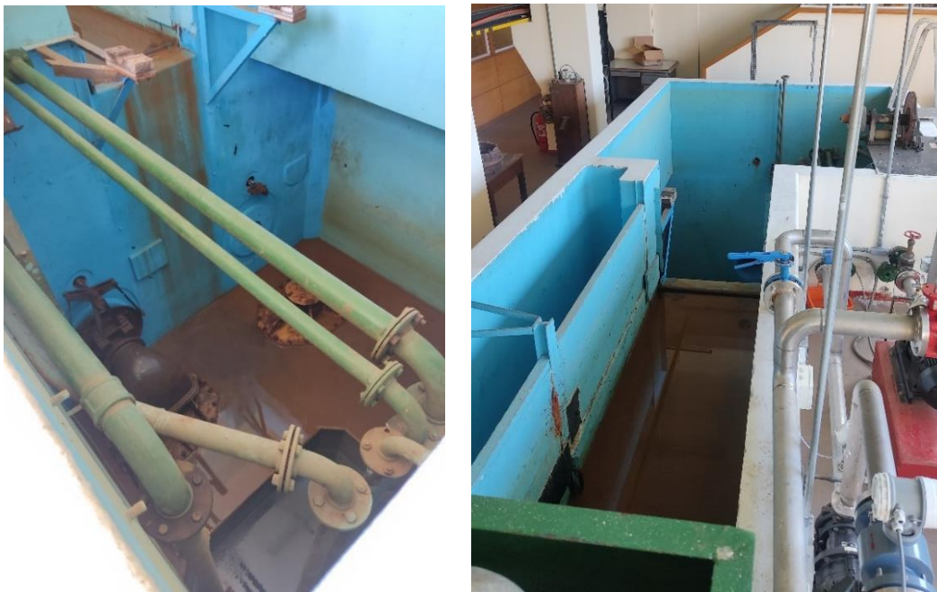
Figura N°21: Estanque de alimentación y canaleta de descarga de estanque receptor a estanque de alimentación.
