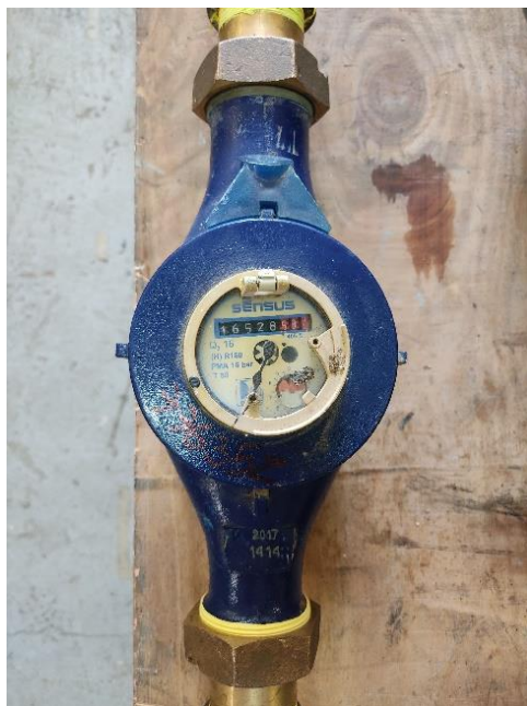
Figura N°28: Medidor general retirado.
