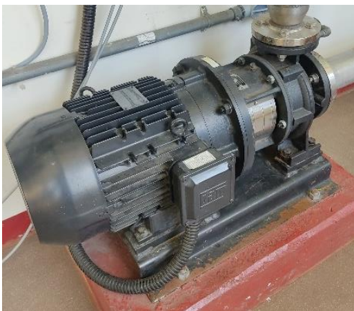
Figura N°16: Bomba centrífuga de alto caudal y características técnicas.
