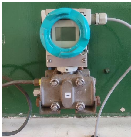
Figura N°18: Sensor de presión hidrostático.
